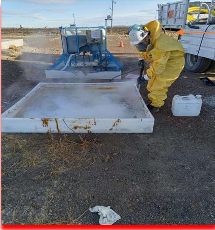
Al momento de empezar con el lavado de bandeja, se observa como se genera un vapor, esto es por la temperatura de agua y que a su vez se mezcla con el remanente de químico generando un vapor contaminado.
