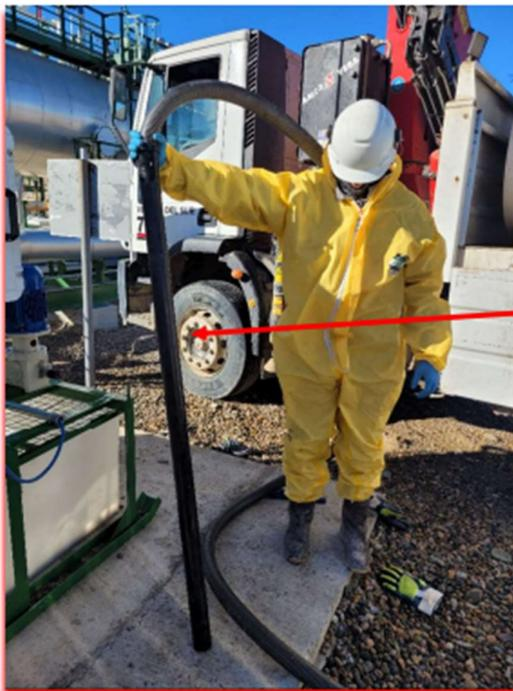
Extensión de PVC rígida para evitar posturas forzadas a la hora de realizar el succionado de bandeja
