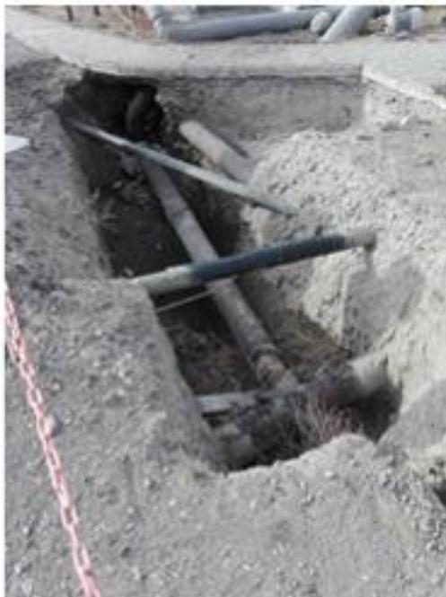
Aislamiento de energía con doble bloqueos hacia by-pass
