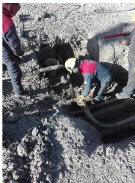
*Aislamiento con plaqueado y obturación de cañería con bentonita para trabajos en caliente en cañerías de petróleo y/o gas.*
