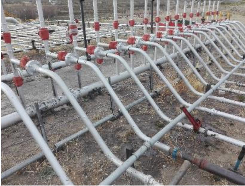
*Siempre que exista la posibilidad se desvinculara la cañería del proceso por ejemplo mediante uniones dobles.*
