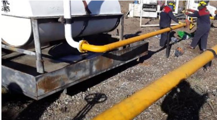
*Siempre los cortes de cañería en servicio se realizan en frío mediante corta caños.*
