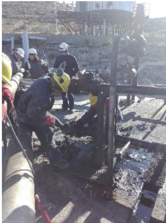
*Aislamiento mecánico con chapas ciegas, de diámetros estandarizados según la presión a soportar, es en última instancia la garantía de bloqueo, dado que cuando se dispone de dos válvulas para garantizarlo, siempre es probable que una permita paso.*
