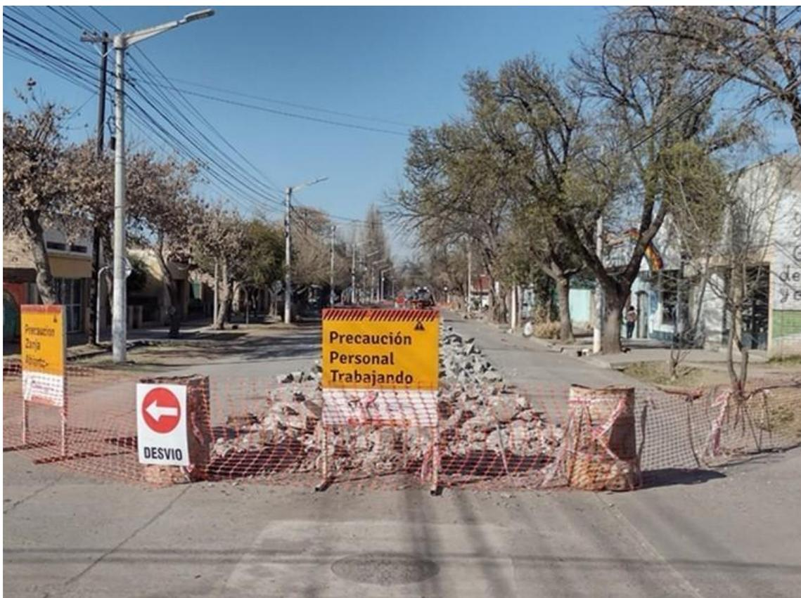
En la red se preverá la instalación de bocas de registros ubicadas de manera de lograr el mejor funcionamiento de la red, estas bocas de registros poseen una cámara de limpieza de 1,20 MTS de diámetro interior, con un tramo final con profundidades que rondan los 4 metros, implica romper asfalto, realizar excavaciones, colocar cañería, realizar registros de hormigón.
