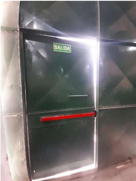
En la imagen se puede observar que la puerta de salida de emergencia se encuentra correctamente señalizada y con baranda antipánico, dicha puerta se abre hacia el exterior, función correcta ya que ante un echo de emergencia no interrumpe el escape.
