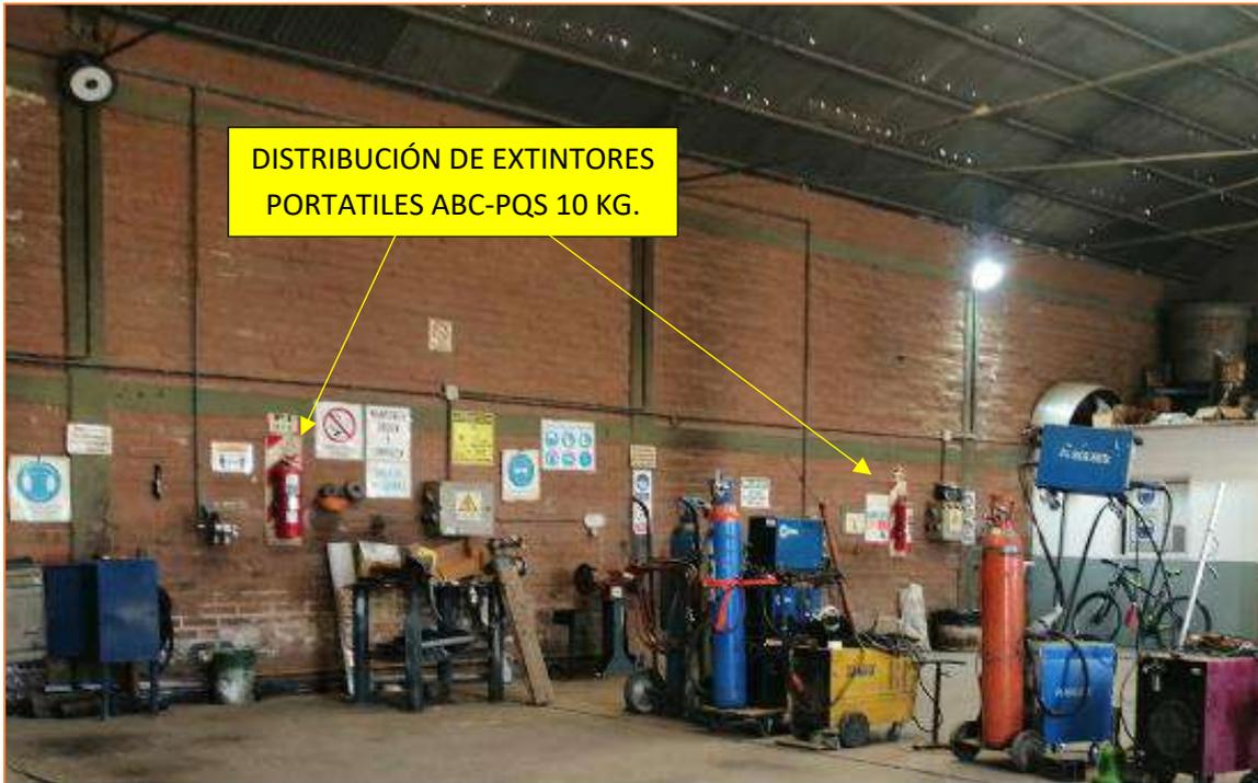
Imagen N° 67 - Ejemplo de distribución de extintores en taller de reparaciones.
