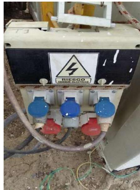
Cada trailer posee dos disyuntores diferenciales, uno en el equipo de aire acondicionado y el otro de funcionamiento general.
