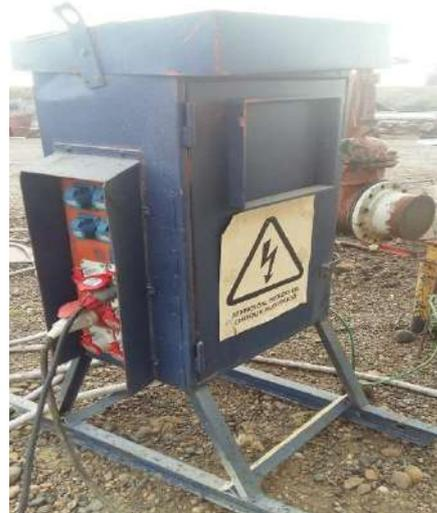
Al tablero general se vincula un tablero seccional que posee un pie para ser trasladado a una posición adecuada de trabajo; este tablero abastece las diferentes herramientas eléctricas que se usan en un lugar determinado.
