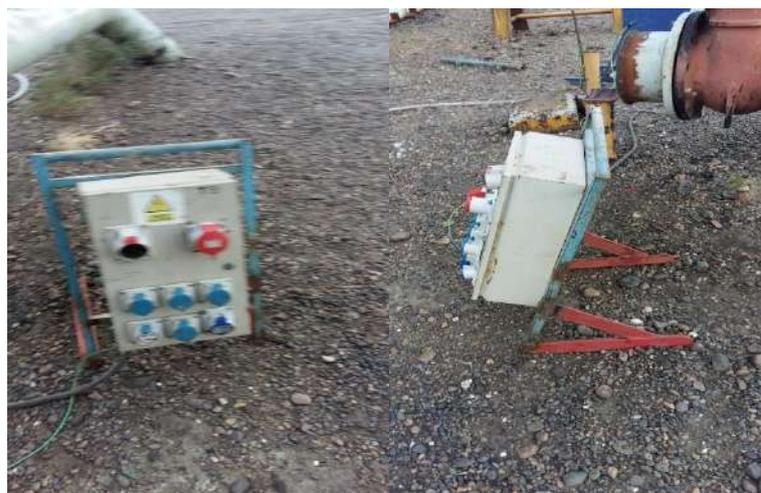
Todas las conexiones poseen disyuntor diferencial y llave térmica que se encuentran en correcto estado de funcionamiento.
