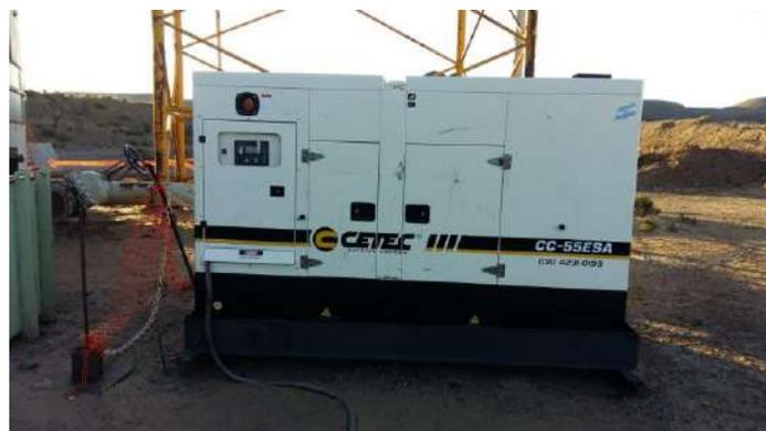
El generador mencionado recientemente abastece un tablero de corte general que es el encargado de proveer energía a las diferentes herramientas y equipos que se encuentran en este sector. Dicho tablero posee una estructura para ser transportado. Posee cuatro conexiones monofásicas hembra y seis conexiones trifásicas hembra (una de las cuales se encuentra dañada, fuera de servicio y sin
