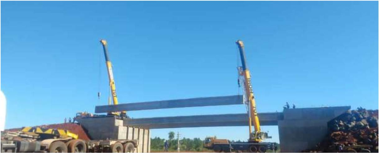
Para una mejor guía en la colocación de las estructuras en sus lugares finales es necesario la utilización de las denominadas “sogas o líneas guía”, las cuales son manejadas por personal capacitado para el trabajo en el izaje de grandes estructuras, manteniendo una distancia segura en los movimientos de estas tareas.
