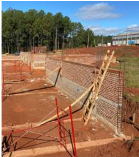
Uso de escalera de madera en obra
