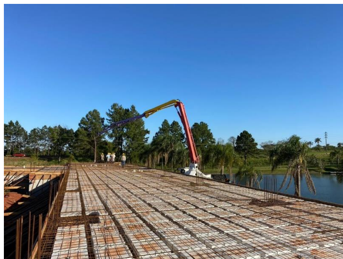
Hormigonado por bombeo
