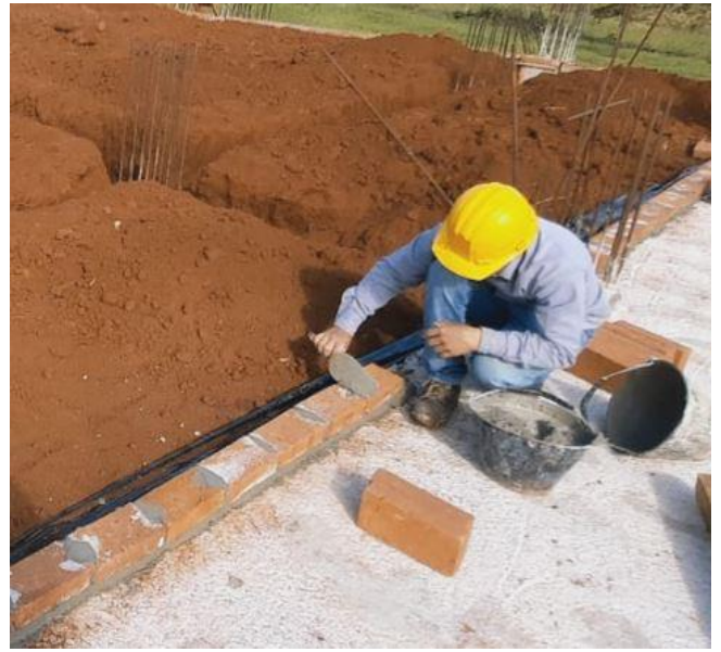
Imagen de colocación de ladrillos
