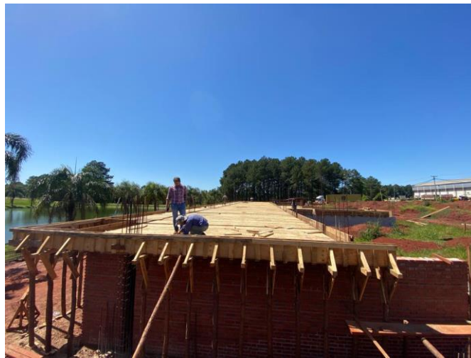
Preparación para el llenado de la losa
