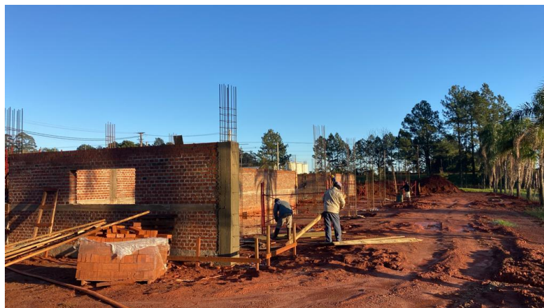
Preparación de las columnas
