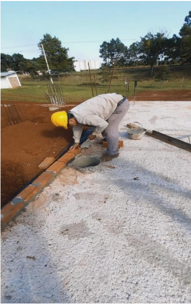
Imagen de colocación de ladrillos
