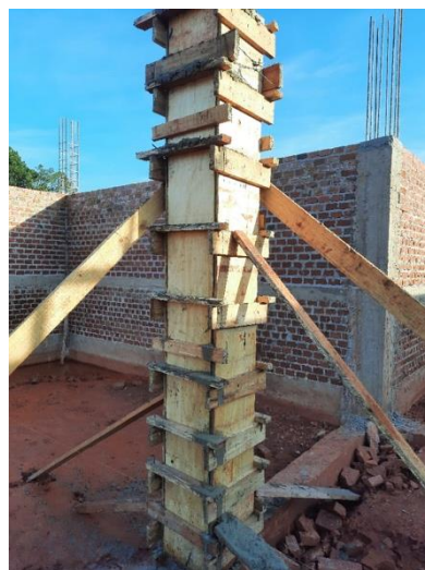
Encofrado de columnas
