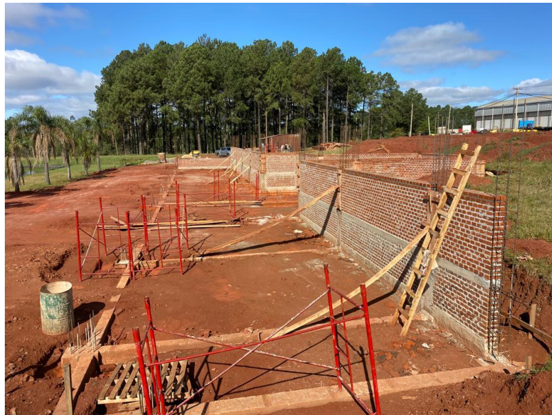
Ejecución de la mampostería
