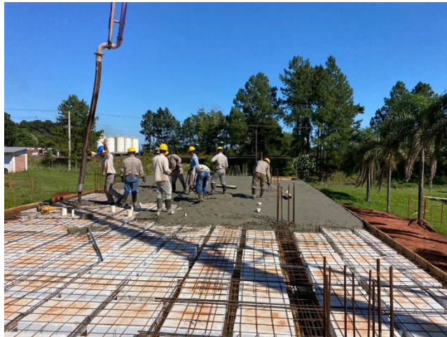
Hormigonado de la losa
