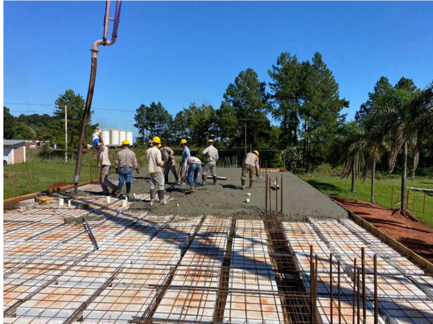
Hormigonado de losa
