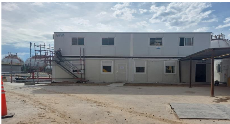
Oficina de Obrador MAGNA
