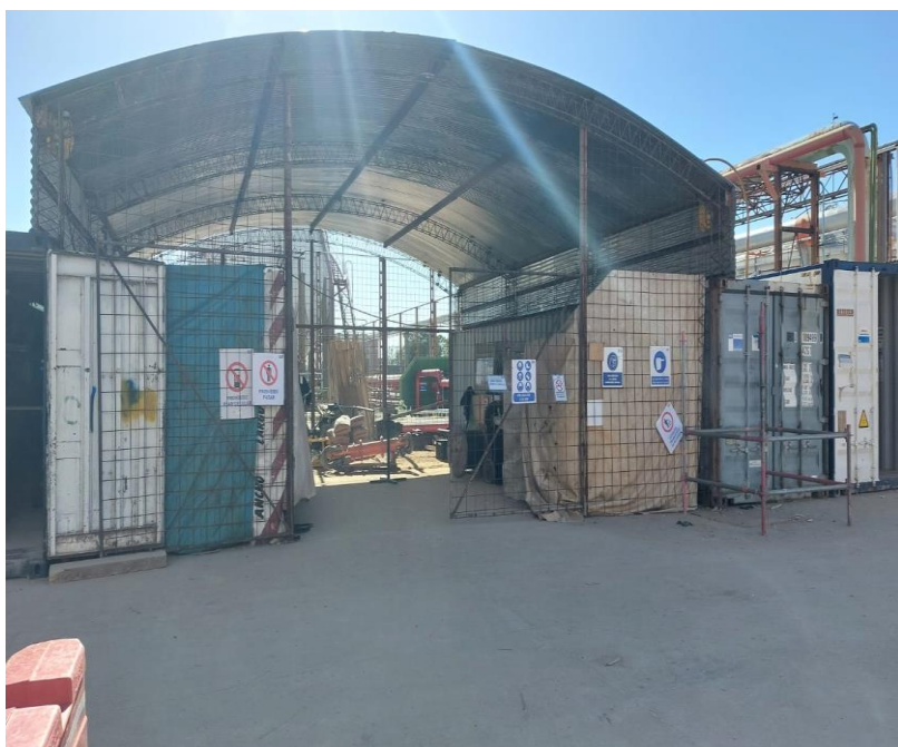
Taller de obra
