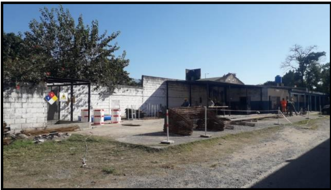
Foto 2 Acopio de estribos para trasladar al frente do obra
