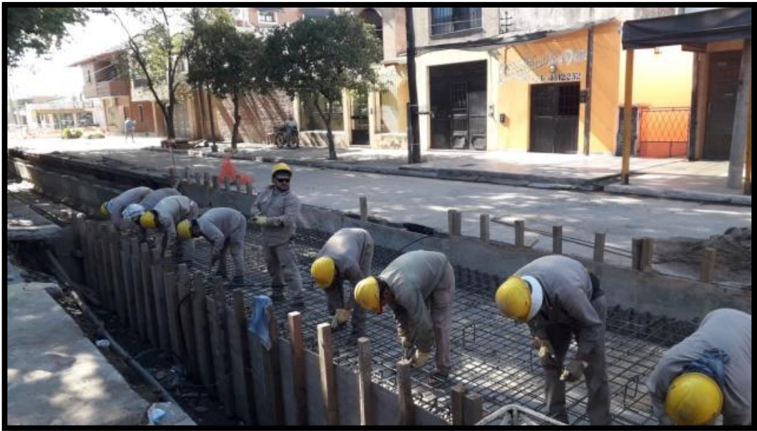
Foto 13 Atado de hierros longitudinales y transversales para armaduras de losa del canal pluvial.
