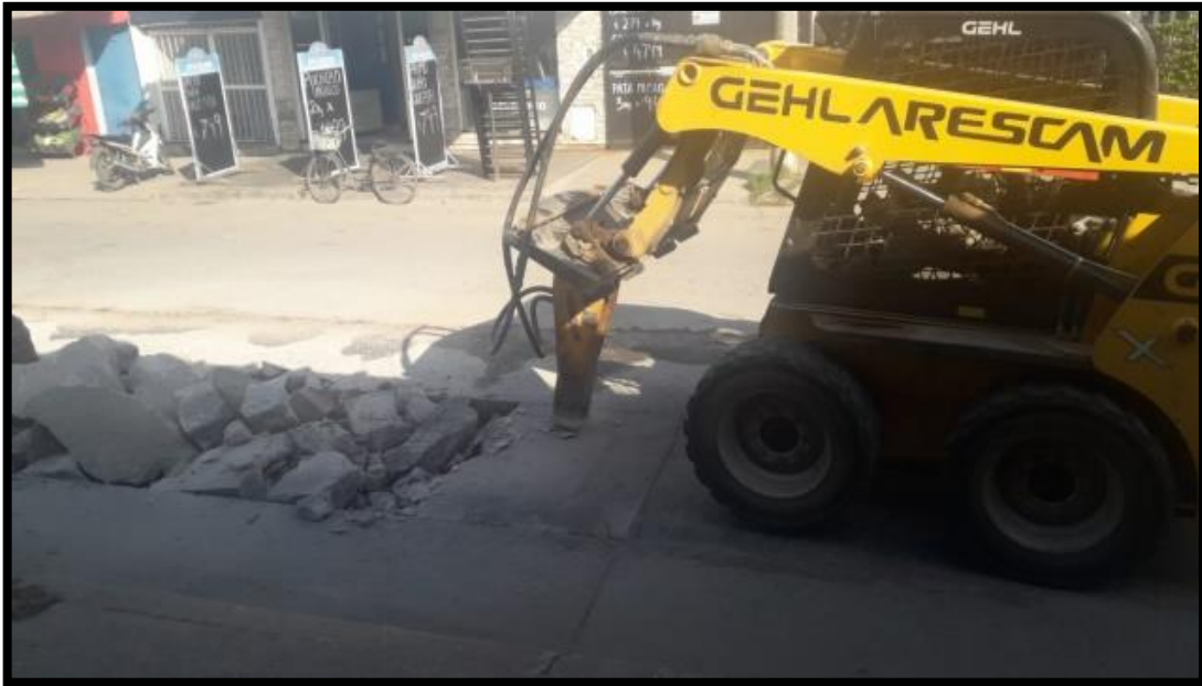
Foto 5 Demolición de pavimento de hormigón con martillo hidráulico de la cargadora mini
