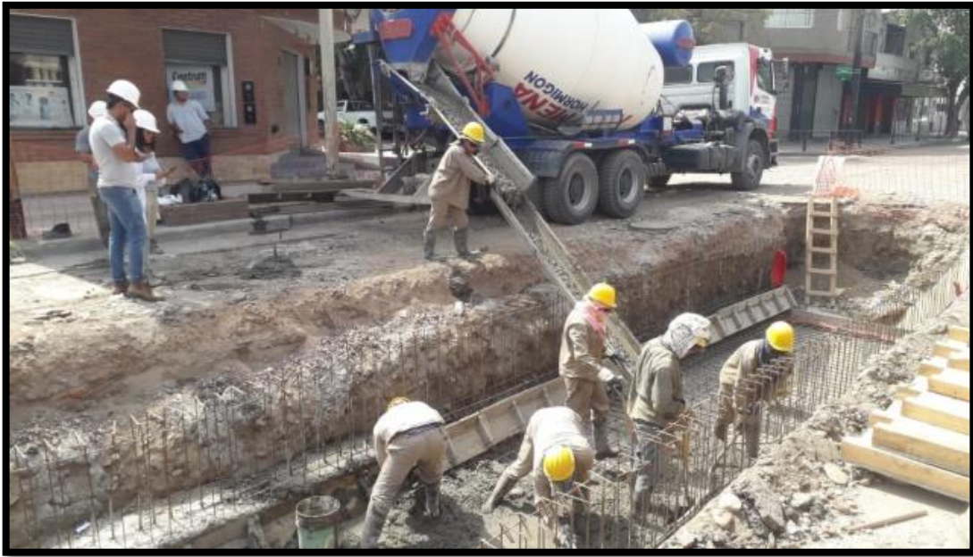
Foto 17 Hormigonado y curado de soleras del canal pluvial.
