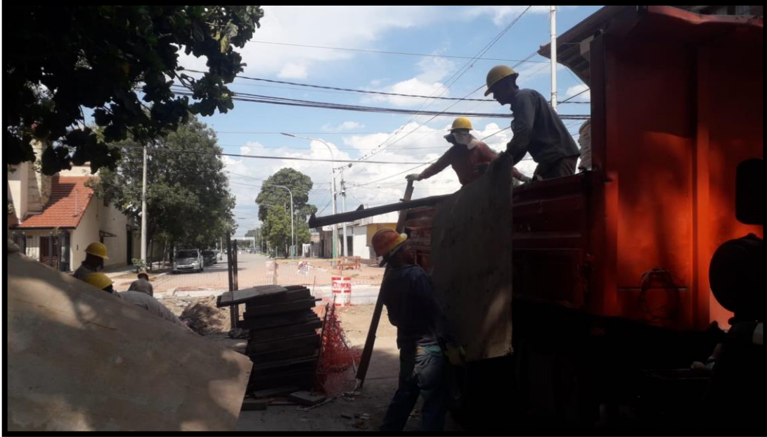
Ilustración 6 carga de tableros para encofrar tabiques y losas del canal pluvial
