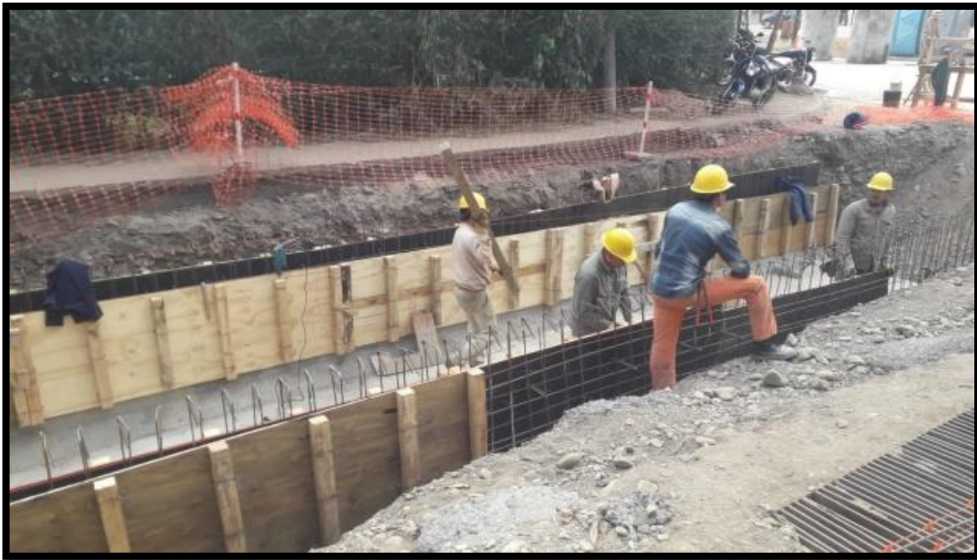
Foto 15 Encofrado de tabiques de canal pluvial
