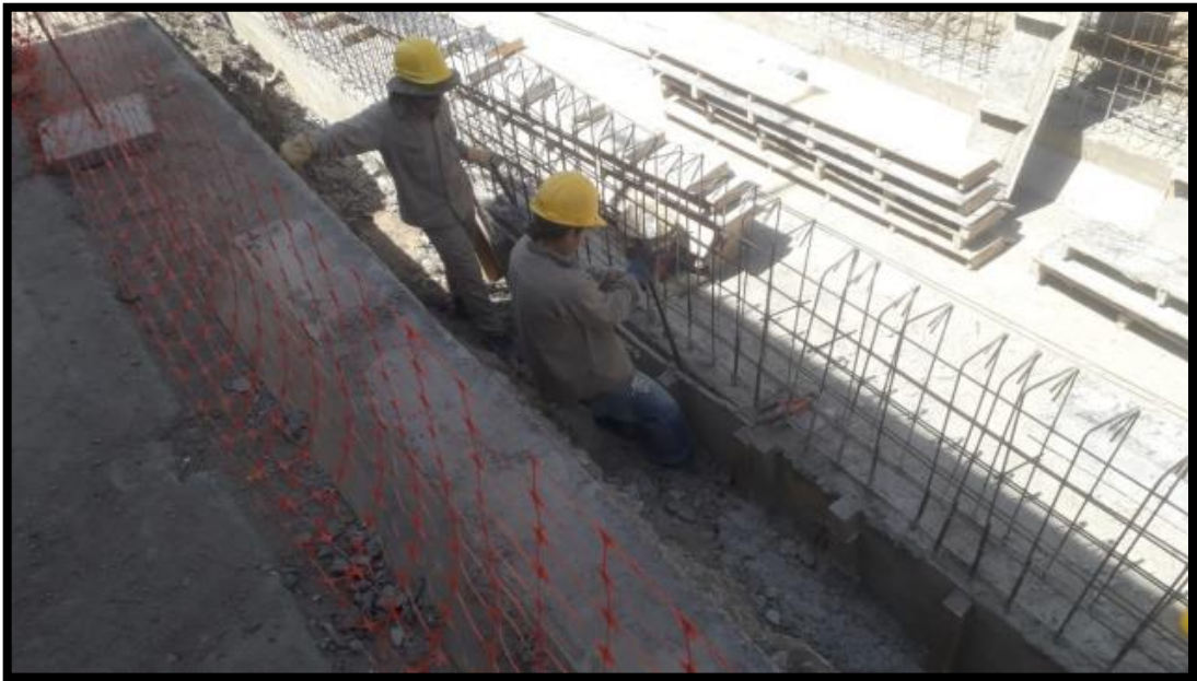
Foto 22 Desencofrado de soleras de canal pluvial
