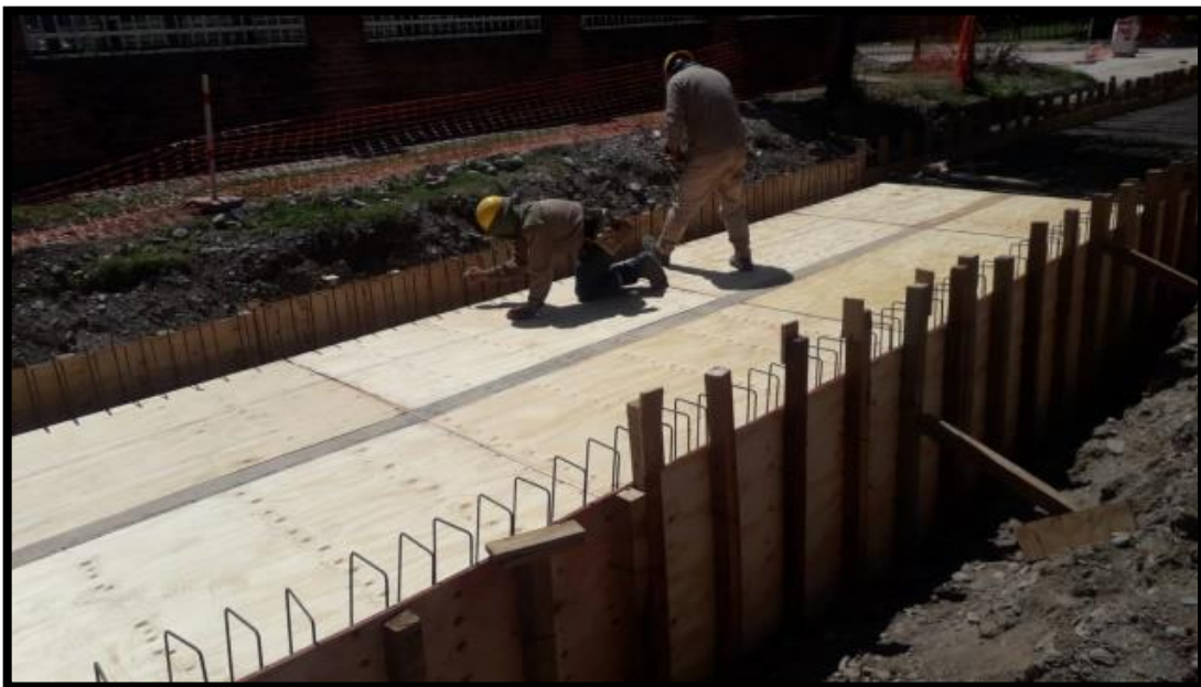
Foto 16 Encofrado de losa del canal pluvial
