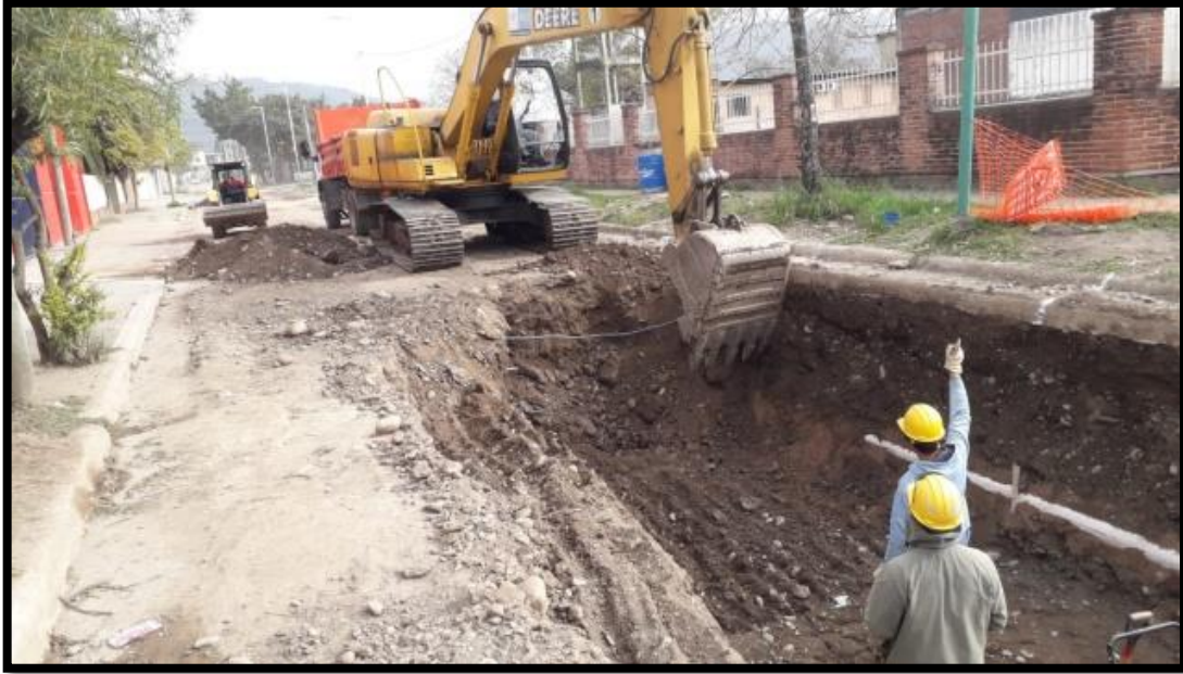
Foto 9 Excavación de canal con retro-excavadora más de 1.2 metros de profundidad.
