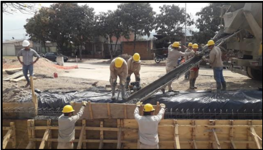
Foto 18 Hormigonado de tabiques del canal pluvial.
