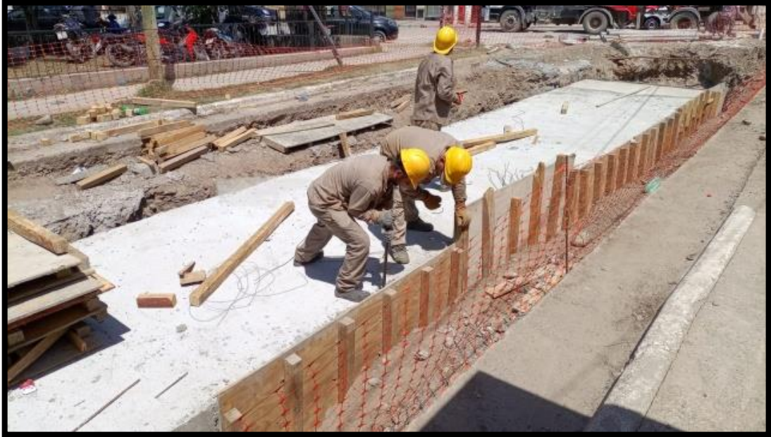
Foto 23 Desencofrado de tabiques de canal pluvial.
