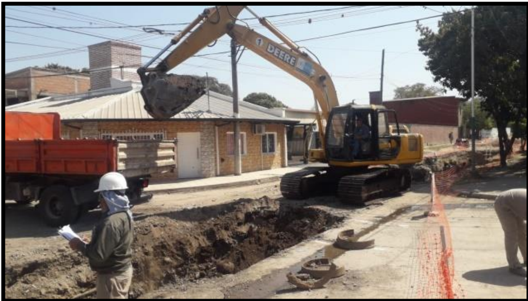
Foto 10 Excavación de canal con retro- excavadora y retiro de excedente de suelo con camión volquete
