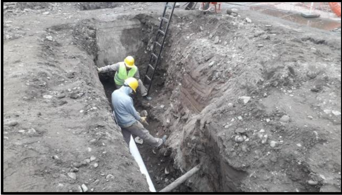
Foto 7 Instalación y conexión de cañerías nuevas de cloacas
