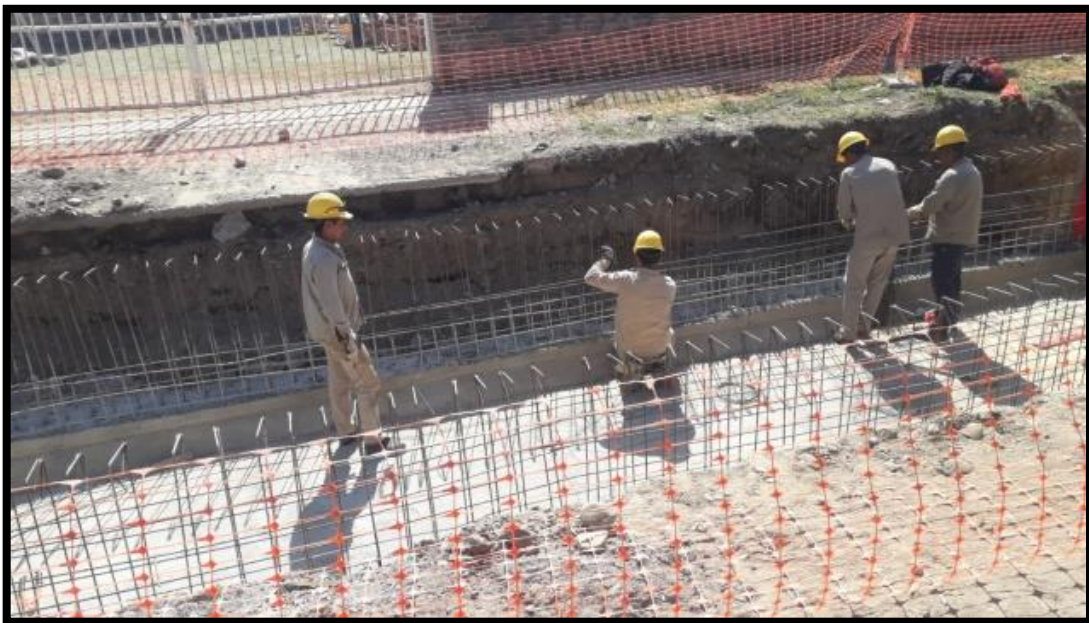
Foto 12 Atado de hierros de distribución para tabiques del canal pluvial
