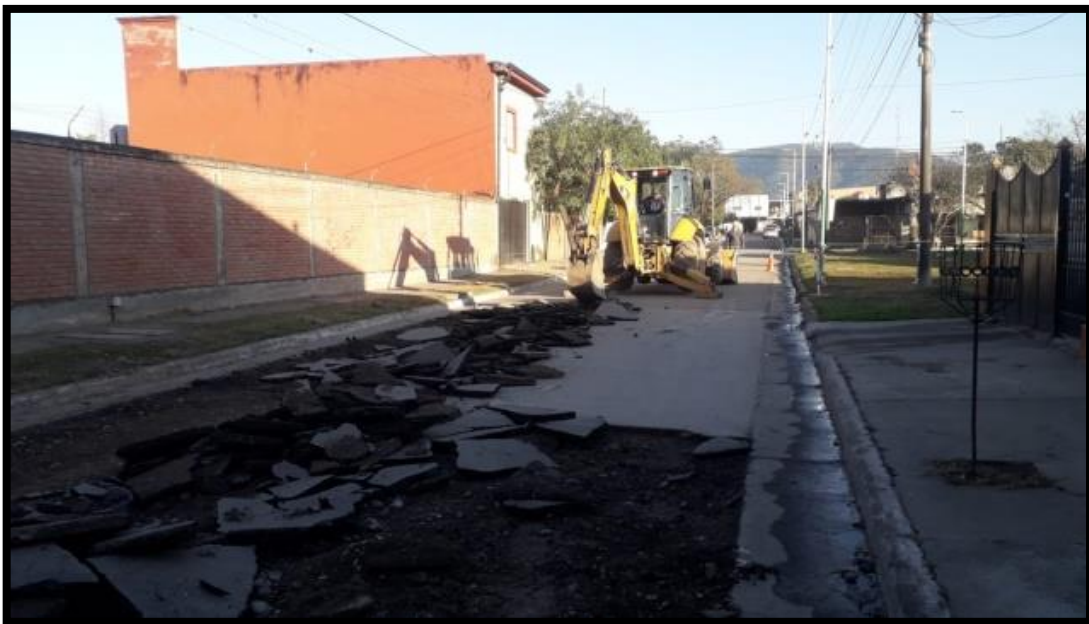
Foto 4 Demolición de pavimento asfáltico con retro excavadora
