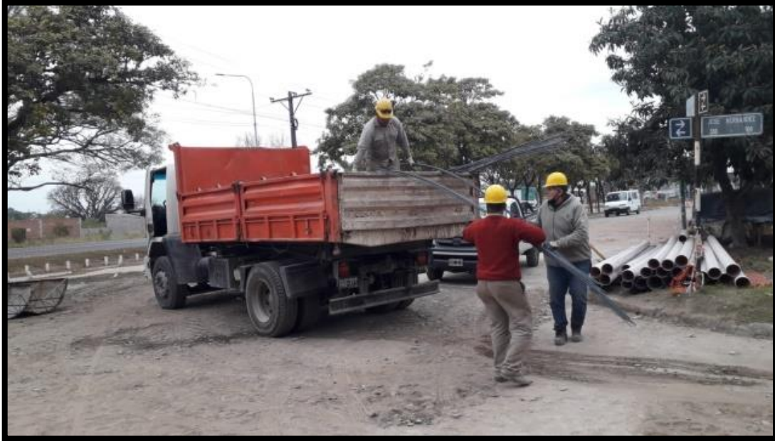
Foto 3 Descarga de hierros y estribos en el frente do obra.
