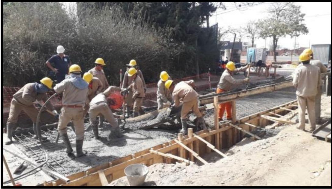
Foto 19 Hormigonado y curado de losa de canal pluvial
