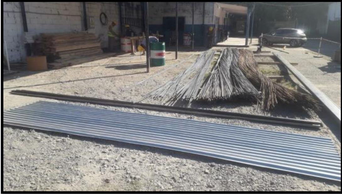
Foto 1 Acopio de hierros que luego son trasladados al frente de obra para distribuciones de soleras, tabiques y losas
