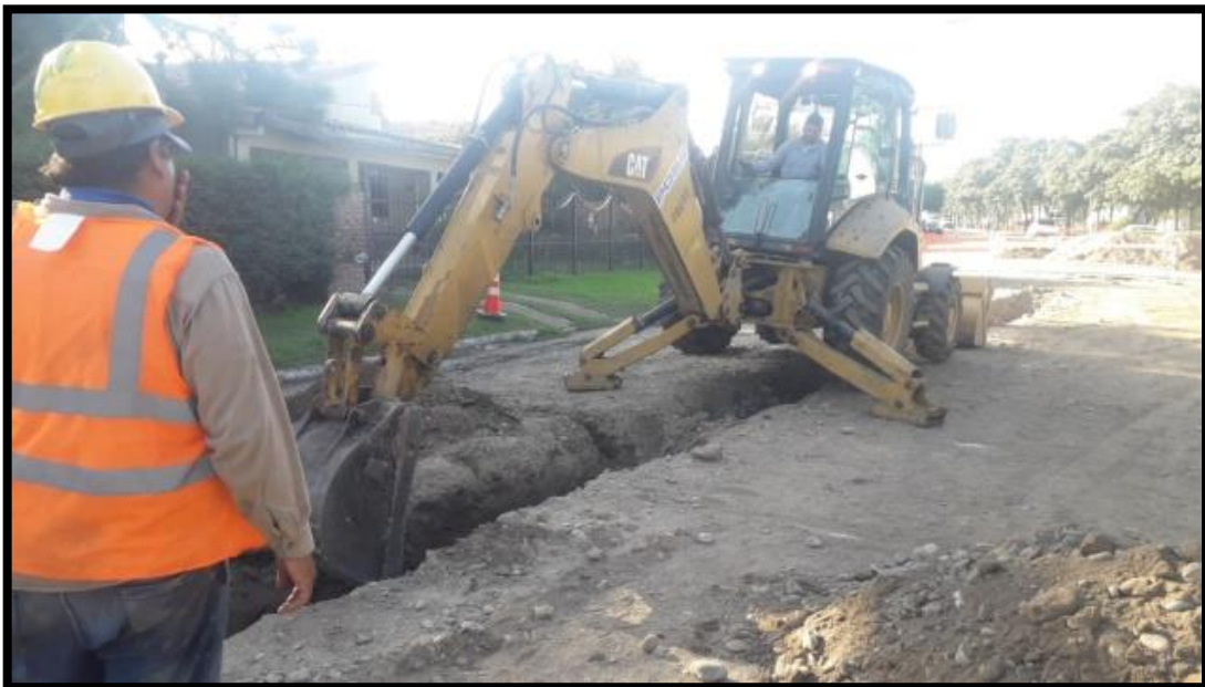
Foto 6 Excavación de zanjas más de 1.2 metros con retro pala para reconfiguración de cañerías de cloacas
