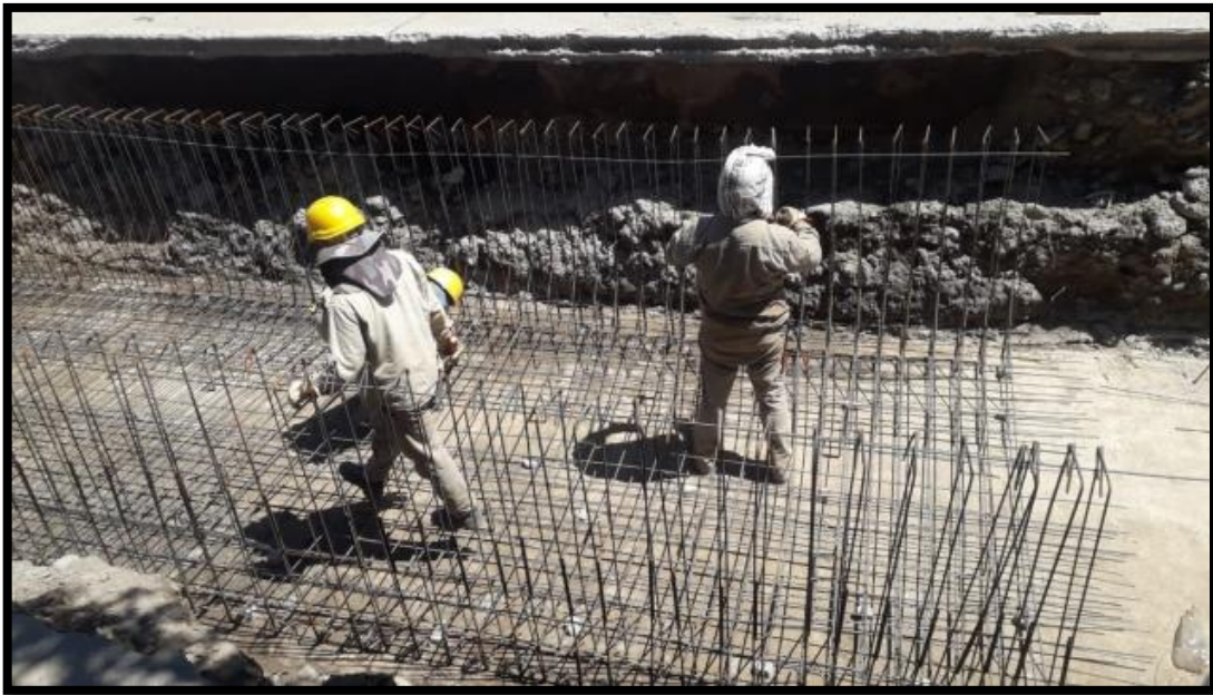
Foto 11 Atado de estribos y hierros de distribución para soleras del canal pluvial
