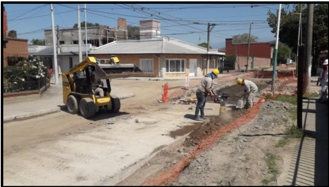
Foto 20 Calzada con ripio ase y compactación con vibro pisón del canal.
