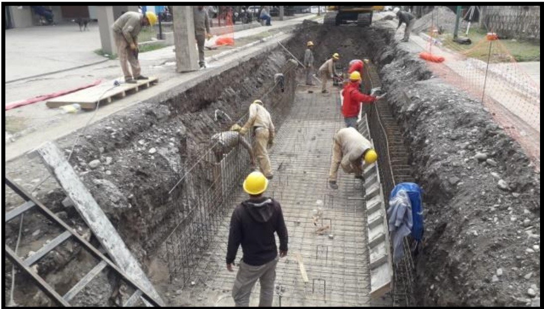
Foto 14 Encofrado de soleras del canal pluvial.
