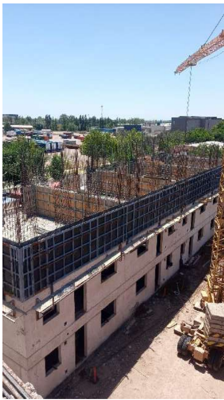
Bloque B – Moldes colocados 3° piso
