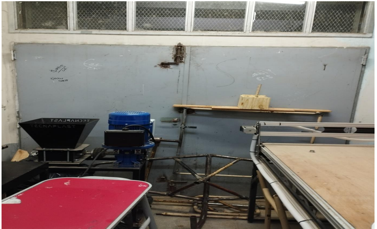
Puerta salida de emergencia sale al patio Bloqueada.
