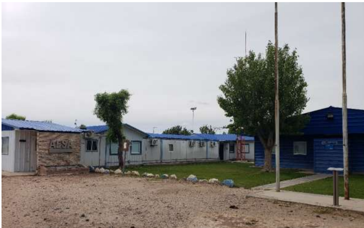
Obrador de Servicio de Soldadura
