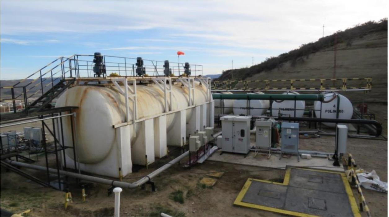
Imagen N° 5: Vista de la Platea de Tanques: 1 tanque reactor y 4 tanques de stock. Se observan cámaras de inspección.
