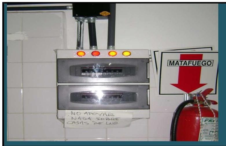
Figura 3.18 Los tableros eléctricos se encuentran sin señalizar
