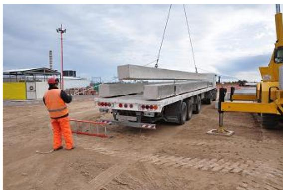
Figura 7 - Carga y descarga de pilotes sobre camión.
