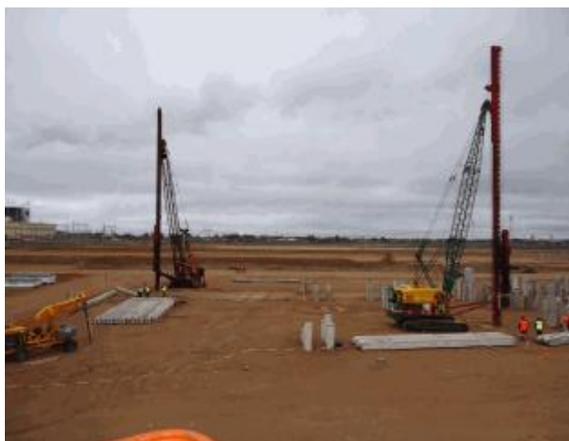
Figura 5 - Acopio de pilotes en el frente de hincado.
