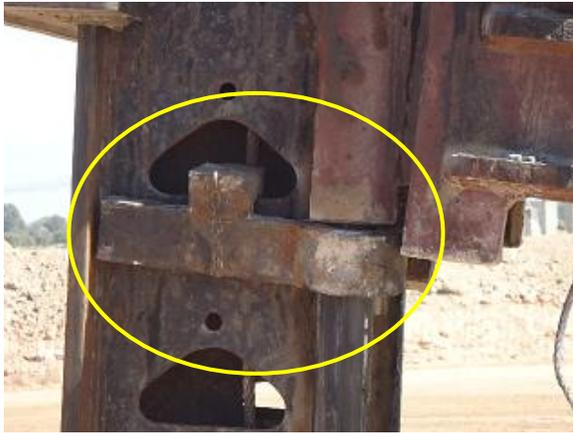
Figura 15 - Colocación de bloqueo mecánico
