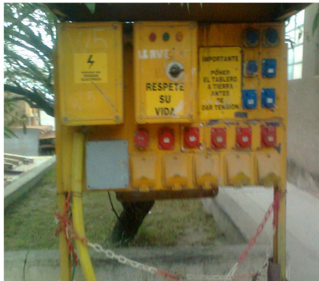
Figura 3.3 Tablero secundario
