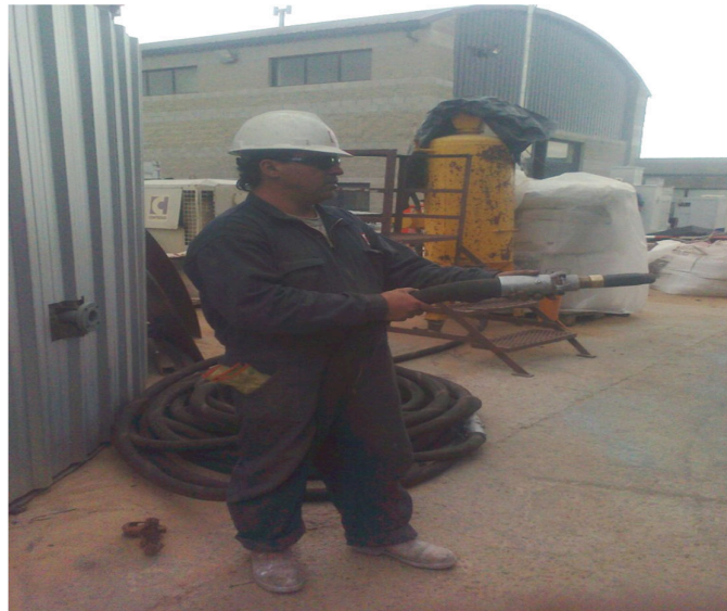
Figura 5.1 Posición del trabajador arenando.
