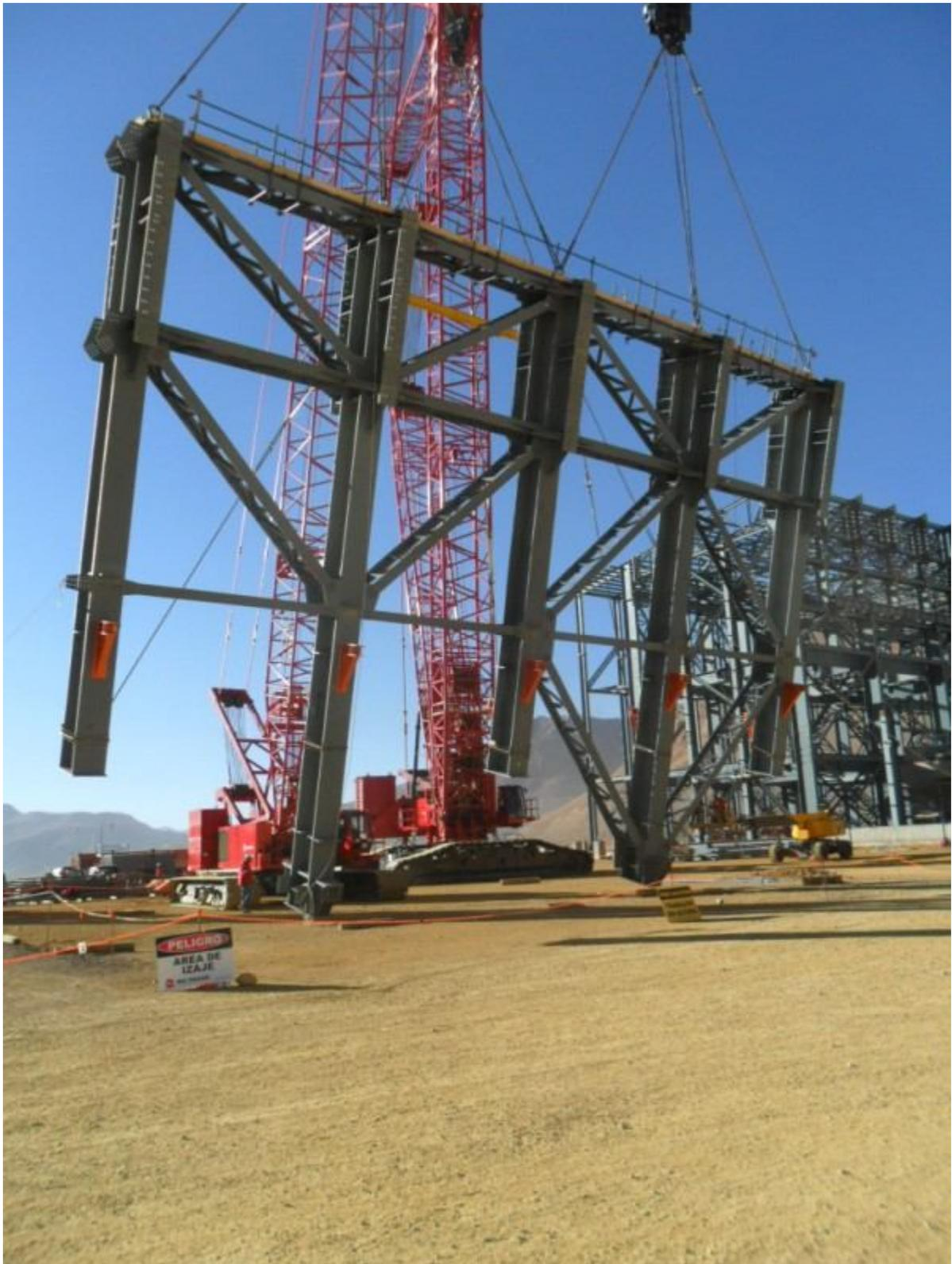
**Figura 2.5 – Verticalización con dos grúas**
