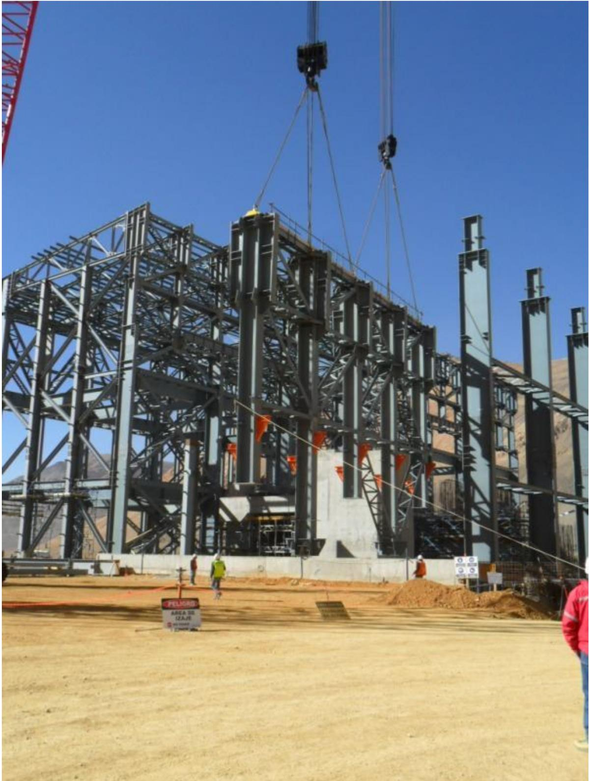
**Figura 2.7 – Izaje. Traslado de estructura con dos grúas**
