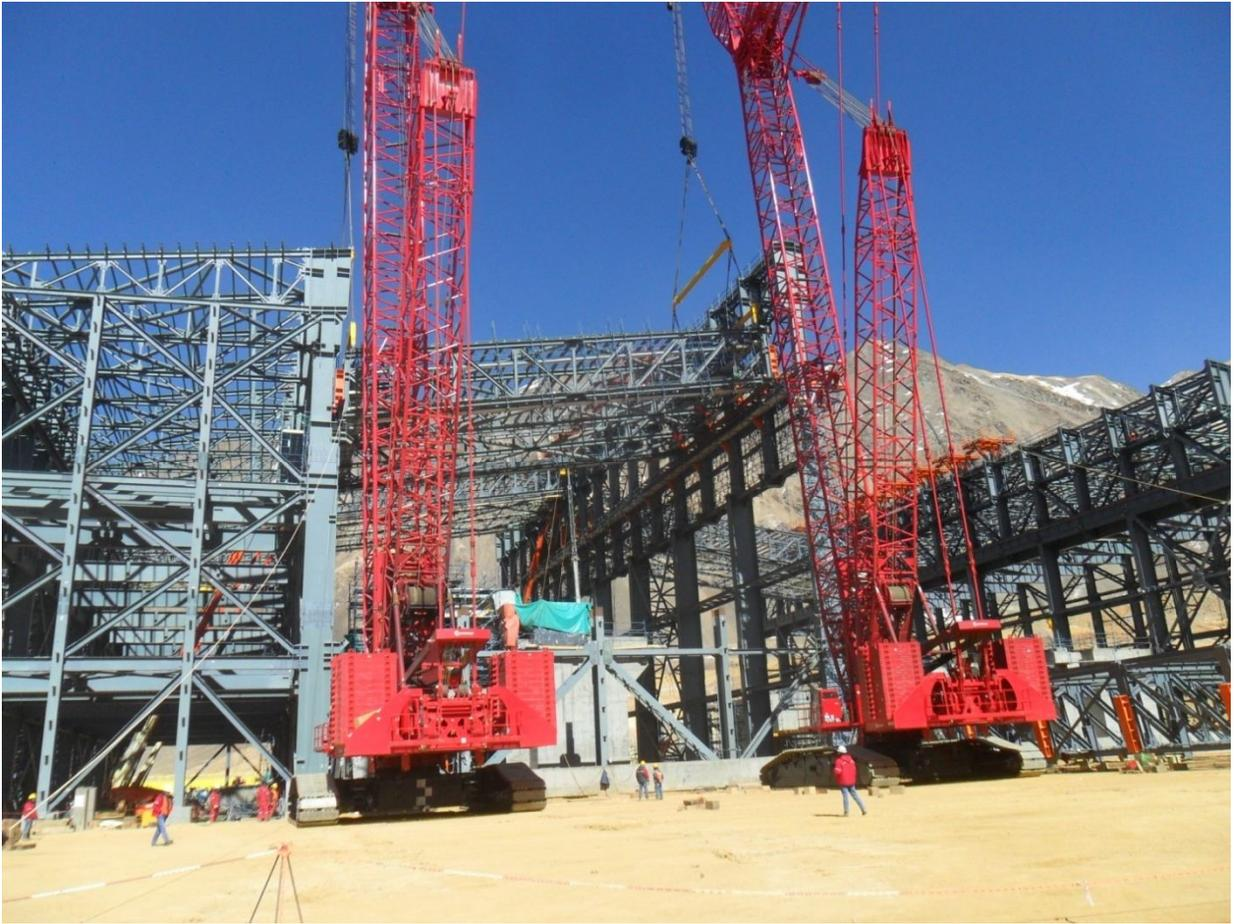
**Figura 2.33 – Izaje tramo de techo con dos grúas móviles tipo oruga 600 TN**
