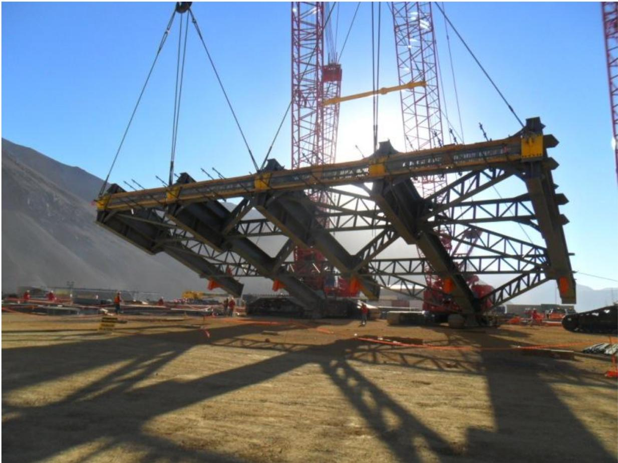
**Figura 2.4 – Verticalización con dos grúas**
