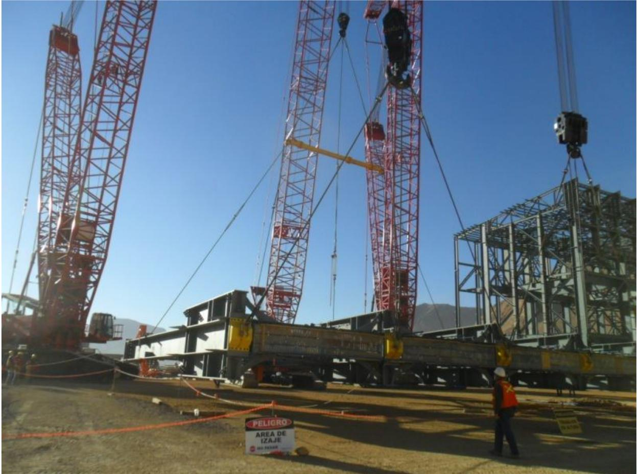
**Figura 2.3 – Prearmado y eslingado de estructura**
