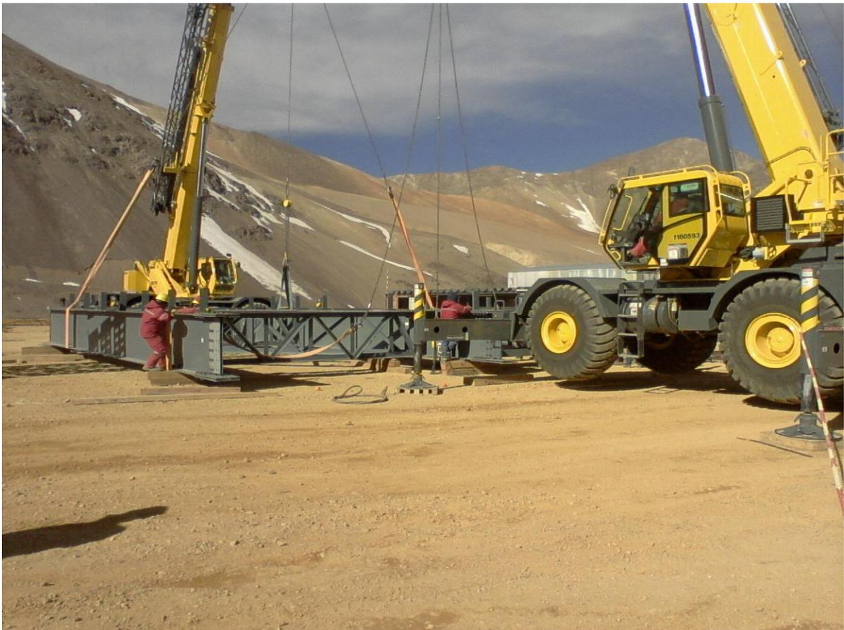
**Figura 2.30 – Prearmado de estructura con grúa móvil sobre ruedas de 90 TN**
