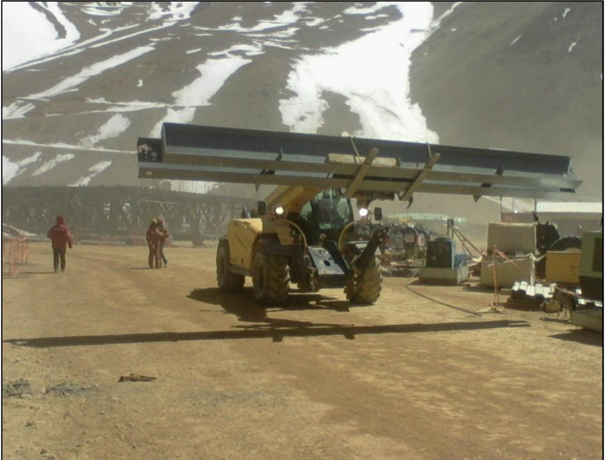
**Figura 2.2 - Traslado de estructura con manipulador telescópico**
