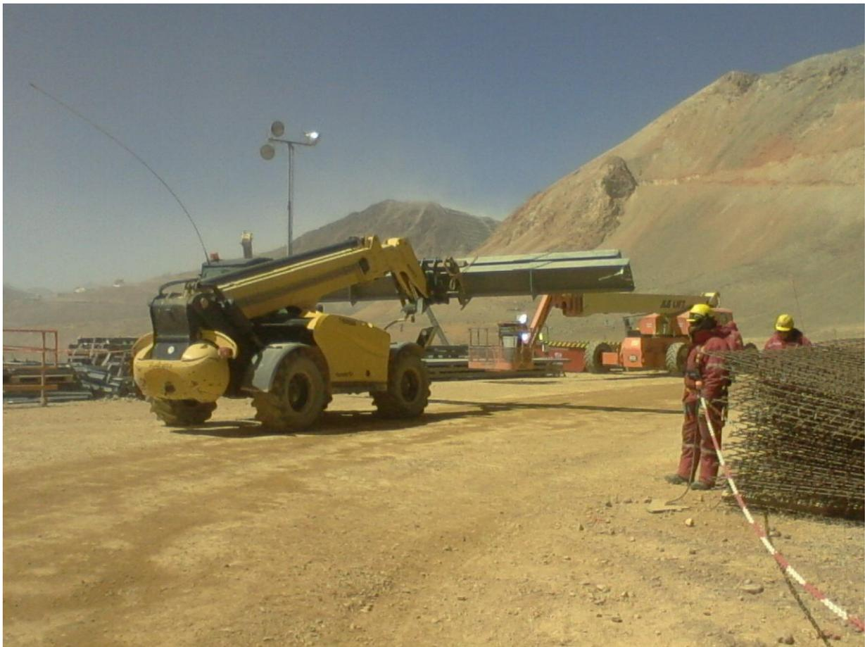
**Figura 2.36 – Transporte de materiales con manipulador telescópico.**
