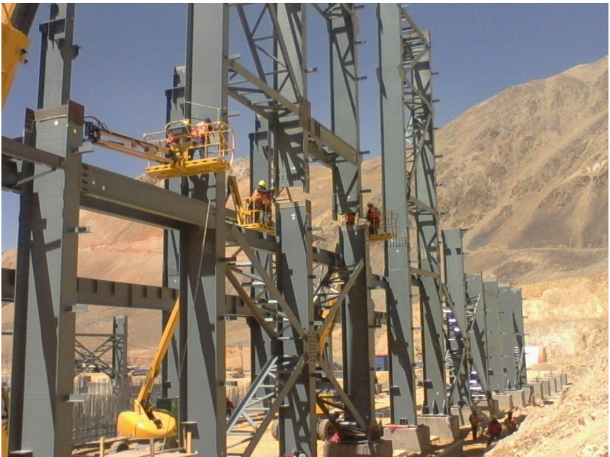
**Figura 2.8 – Posicionamiento y torqueo de bulones**
