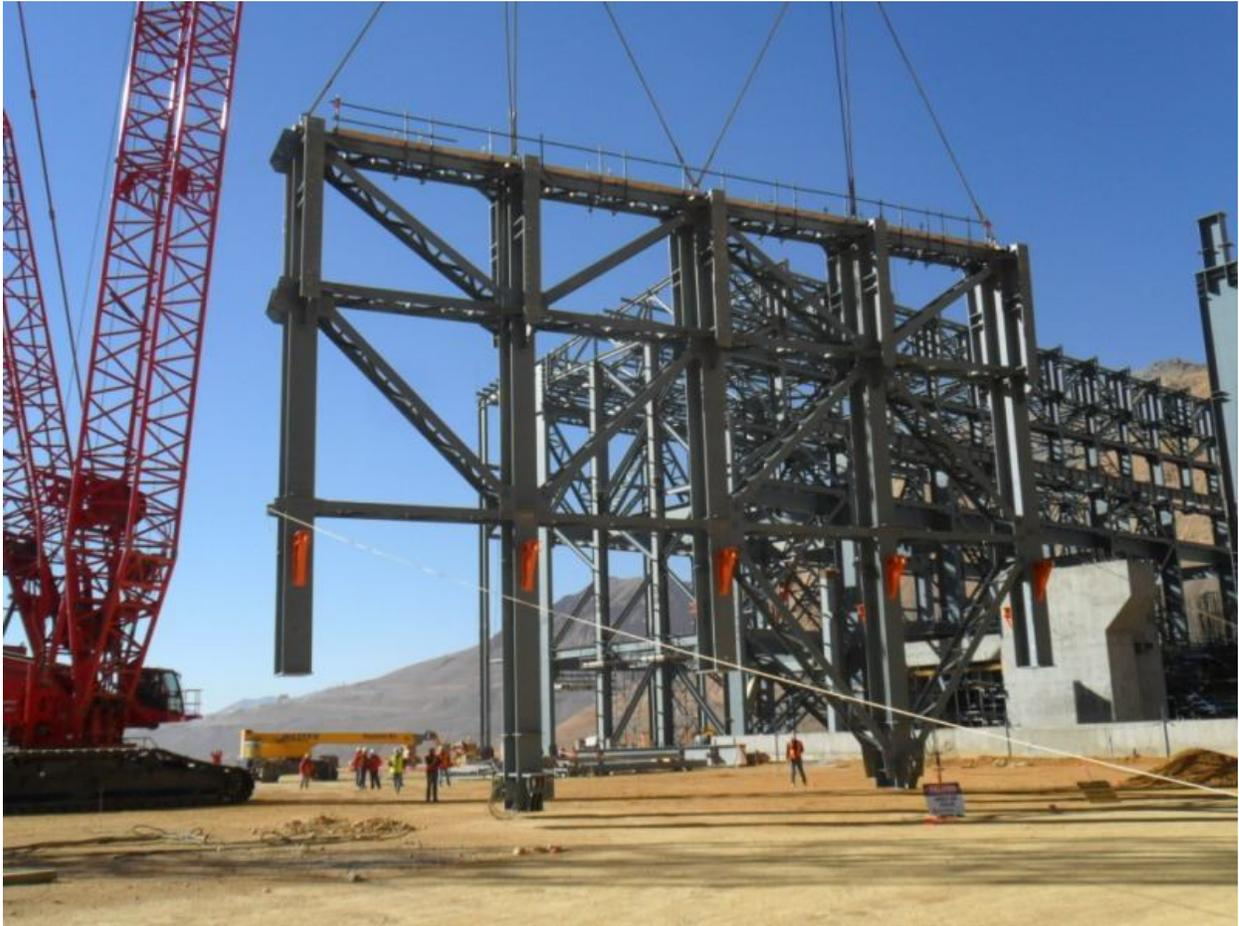
**Figura 2.6 – Izaje. Traslado de la estructura con dos grúas**
