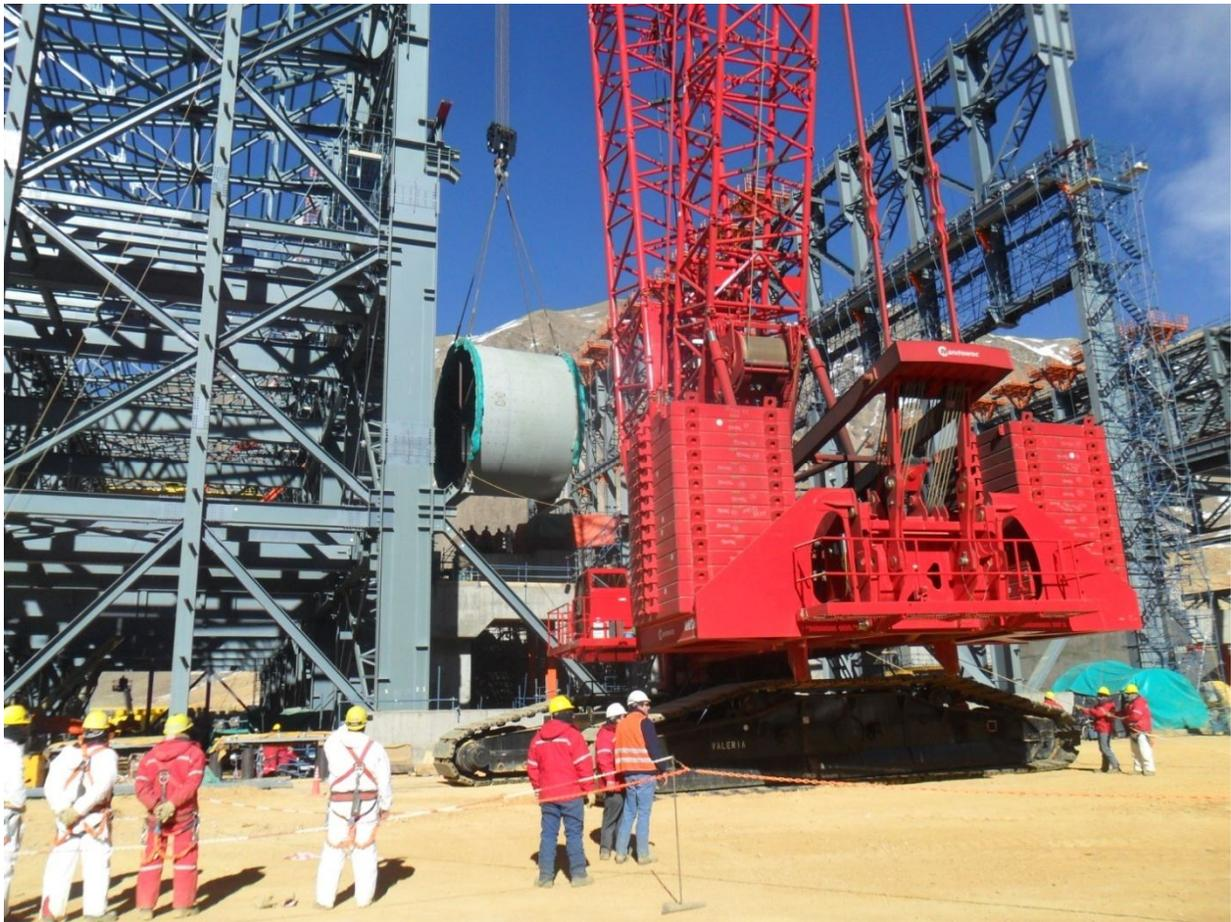
**Figura 2.34 – Izaje tramo de molino con grúa móvil tipo oruga de 600 TN**
