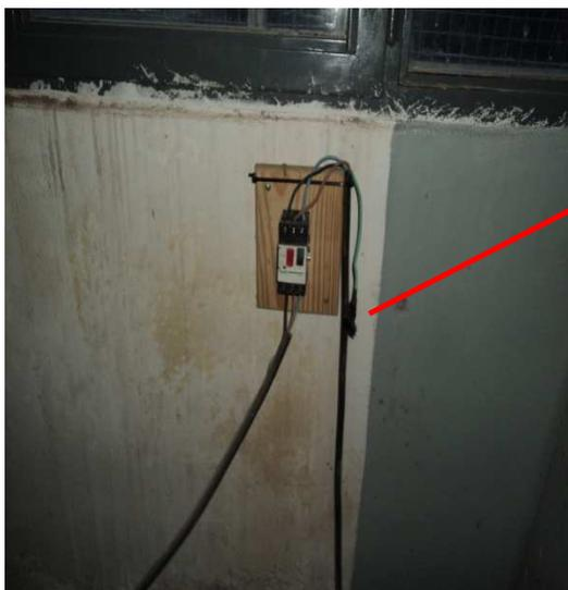
Cables con conexiones empalmadas y dejadas al descubierto
