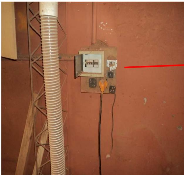
Caja abierta y tomacorrientes en condición insegura. Con restos de aserrín. Riesgo de incendio
