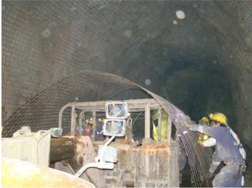
Foto N° 16 Se observa personal preparando malla para colocarla en el equipo de levante
