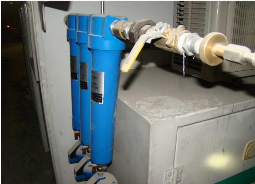
Foto N°63 Sistema filtros para el aire comprimido
