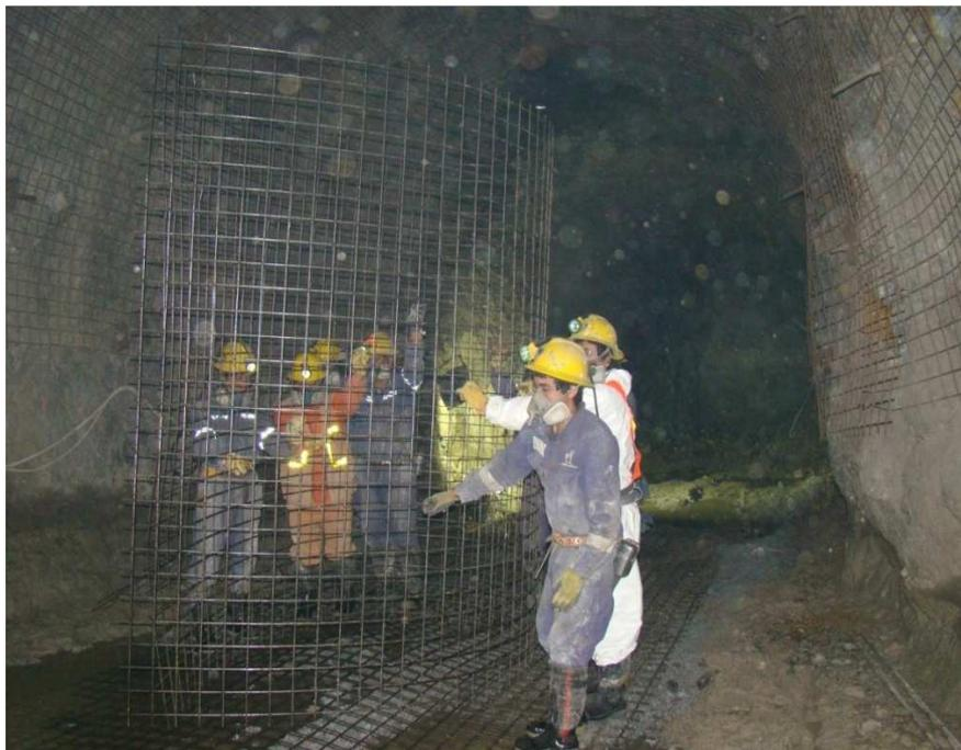
Foto N° 15 Se observa personal preparando malla para colocarla en el equipo de levante
