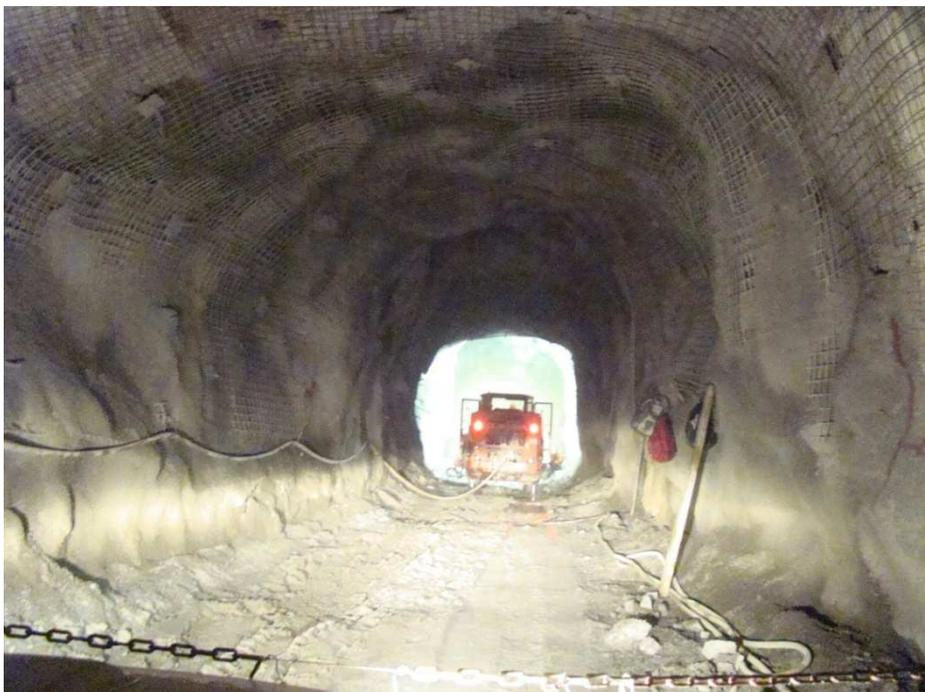
Foto N°32 El frente de trabajo iluminado con lamparas halogeno y el Jumbo con la iluminación del equipo, el resto del tunel sin iluminacion artificial.
