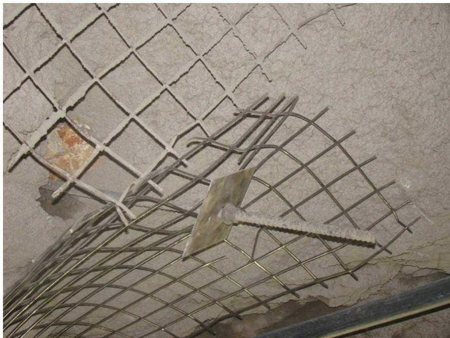
Foto N° 22 Se observa fortificación defectuosa, separada del cerro y No se solapa al menos 30cm
