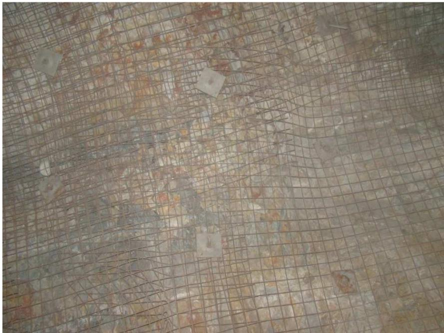
Foto N° 19 Se observa traslape de malla, unido con los pernos y planchuela
