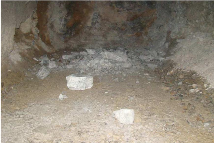
Foto N° 24 Se observa roca desprendida por el tojeo antes de colocar la malla metálica
