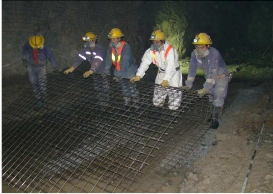
Foto N° 14 Se observa personal preparando malla para colocarla en el equipo de levante
