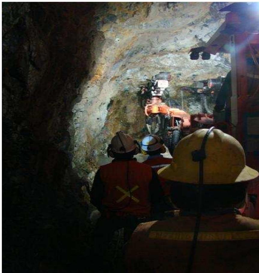
Foto N° 7 Se Observa geomecánicos verificando la perforación para los pernos
