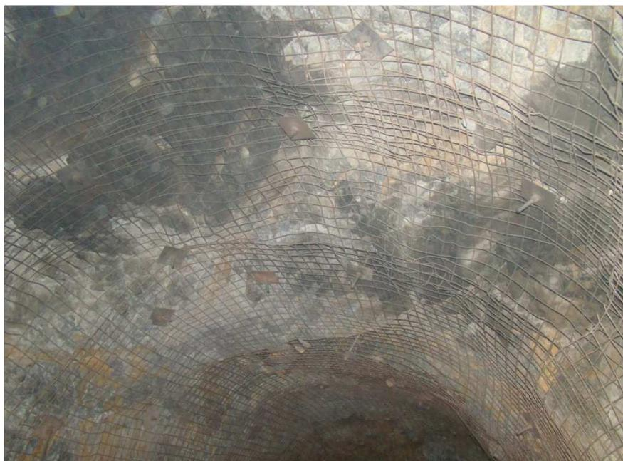
Foto N° 27 Se observa tramos de malla suelta
