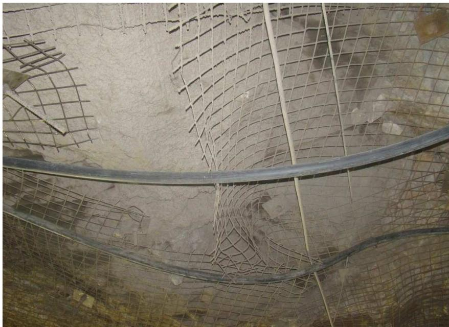
Foto N° 26 Se observa tramo de Malla dañada
