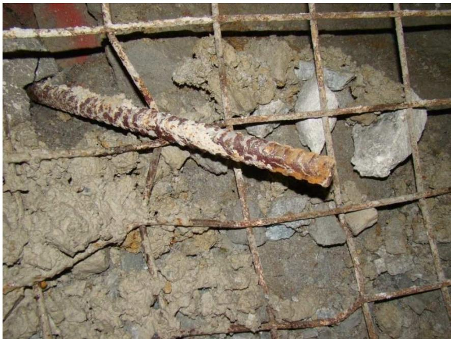
Foto N° 10 Se observa la barra roscada sin su placa y tuerca
