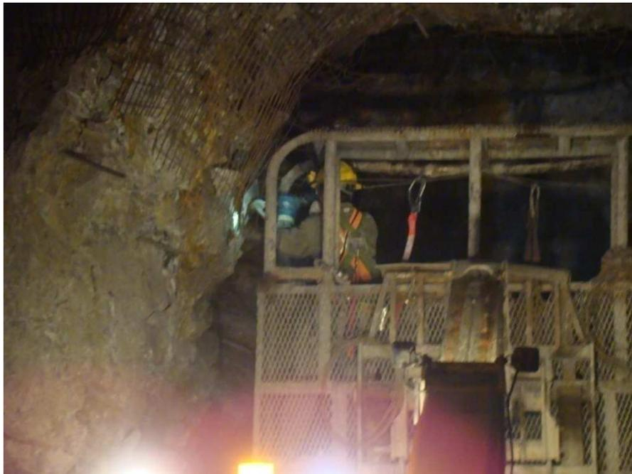
Foto N° 21 Operario retirando la tuerca y planchuela
