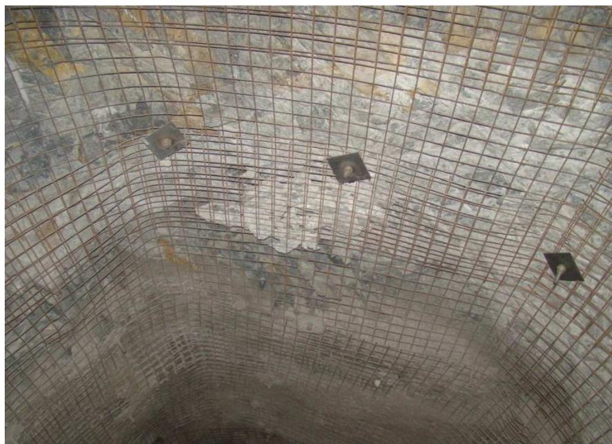
Foto N° 23 Se observa fortificación correcta
