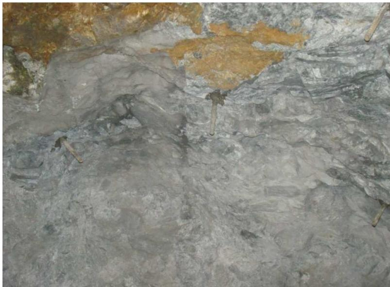
Fotos N° 9 Perno Instalado con inyección de cemento en el techo del túnel
