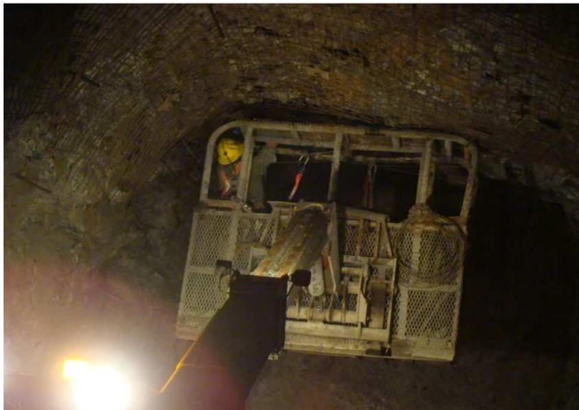
Foto N° 13 Se observa minero inspeccionado los pernos
