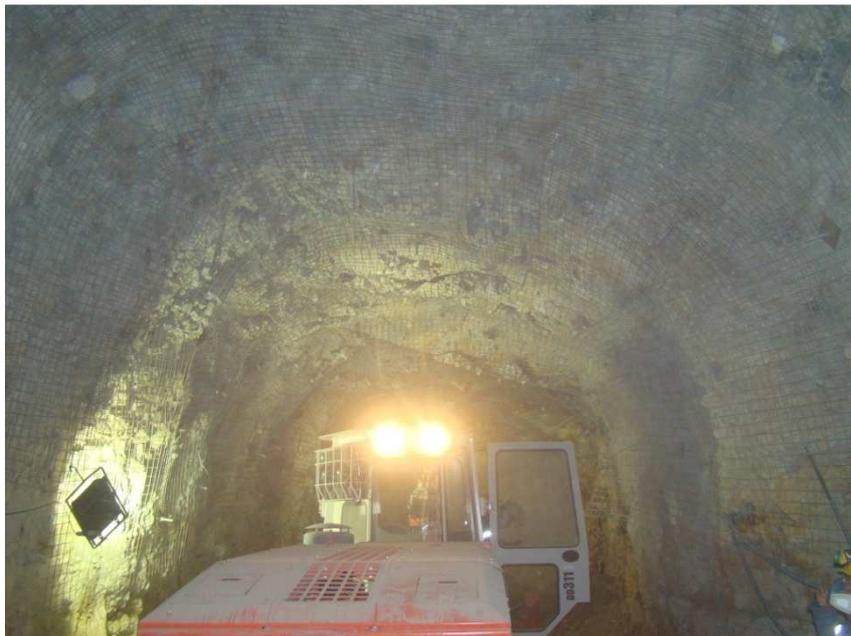
Foto N° 5 Equipo Jumbo – Barreno, entrando al frente de trabajo
