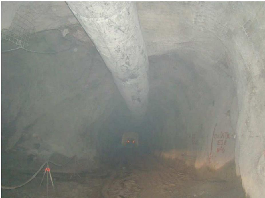
Foro N°33 Se observa la inexistencia de iluminación en gran parte del túnel
