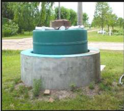
IMAGEN 10. Fotografía y esquema de un gasómetro tipo campana móvil separado del biodigestor. Fuente: "Manual de instalación de un biodigestor familiar tipo manga para zonas alto-andinas". Universidad Politécnica de Cataluña.
