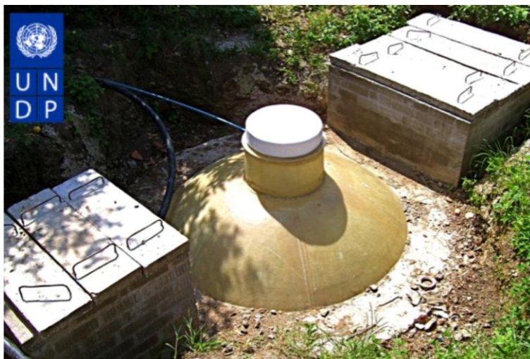
IMAGEN 13. Biodigestor tipo Chino. Fuente: Programa De Desarrollo De Las Naciones Unidas. Disponible en: http://www.tradepusaid.co.za/
