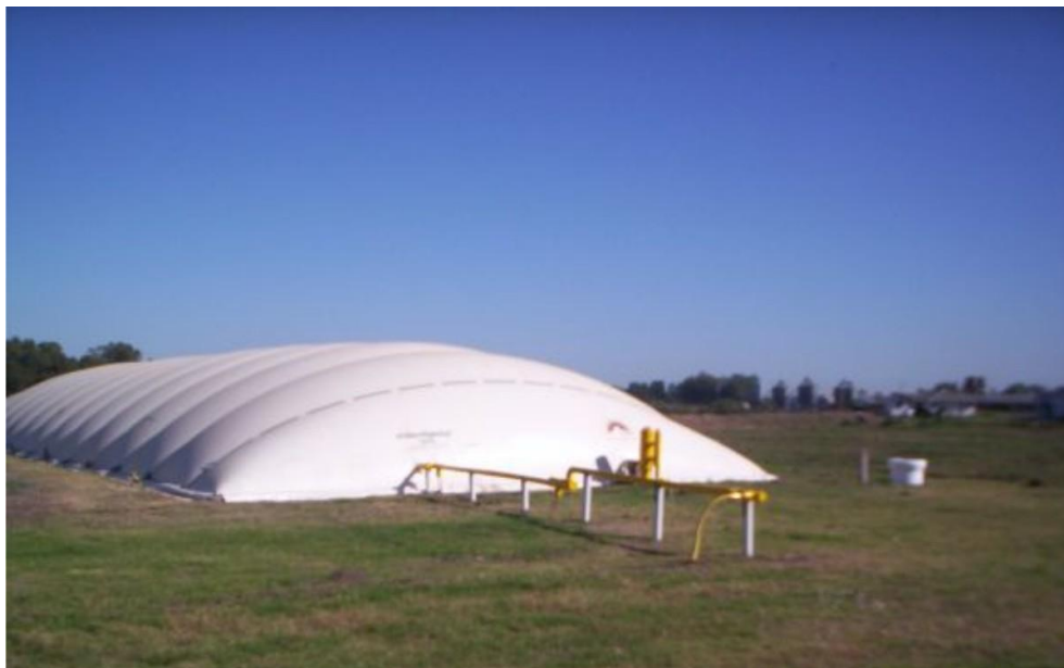
IMAGEN 15. Biodigestor tipo Balón en un emprendimiento de producción porcina en Marco Paz, Buenos Aires. Fuente: Facultad de Ciencia y Tecnología. Universidad Autónoma de Entre Ríos.
