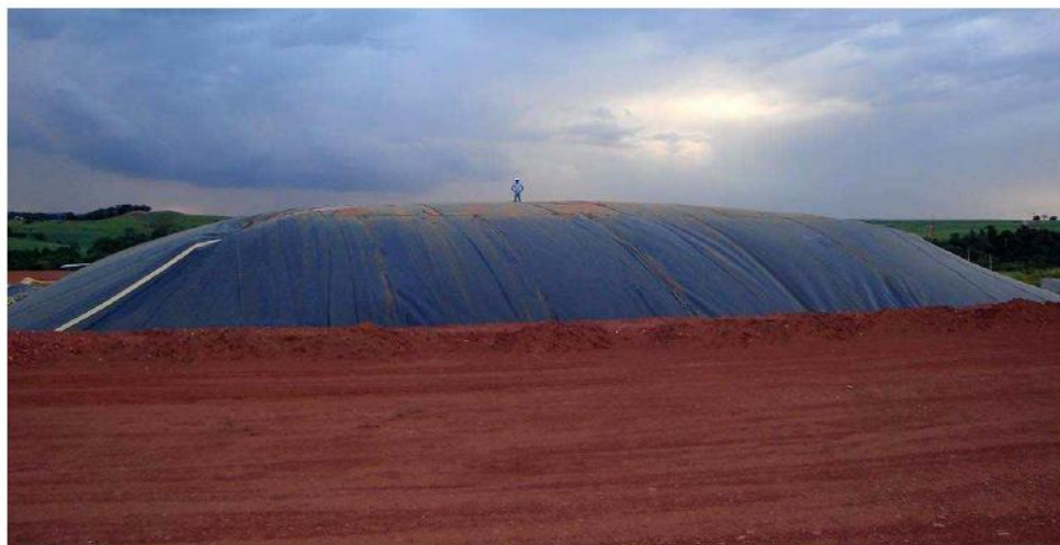
IMAGEN 16. Biodigestor tipo Balón de gran escala. Fuente: Biodigestor con geomembranas. EG-ingeniería, Santa Fe, Argentina. Disponible en: http://www.eg-ingenieria.com.ar/biodigestores-con-geomembranas.html
