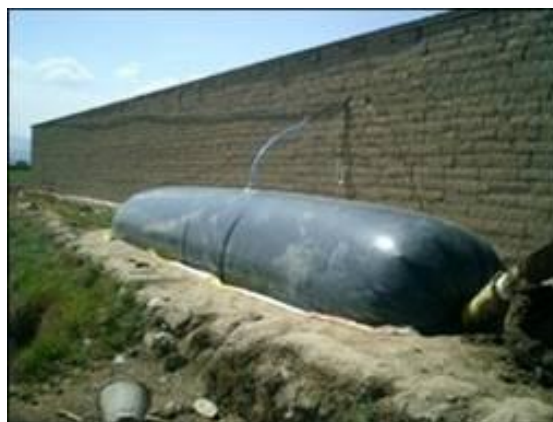
IMAGEN 14. Biodigestor Tipo Balón. Fuente: Torres Guillén, D. y Arteaga Chávez, L. "Desarrollo de un Sistema de Biodigestores y Energías Limpias". Facultad de Ingeniería. Universidad Nacional de Lima, Perú.
