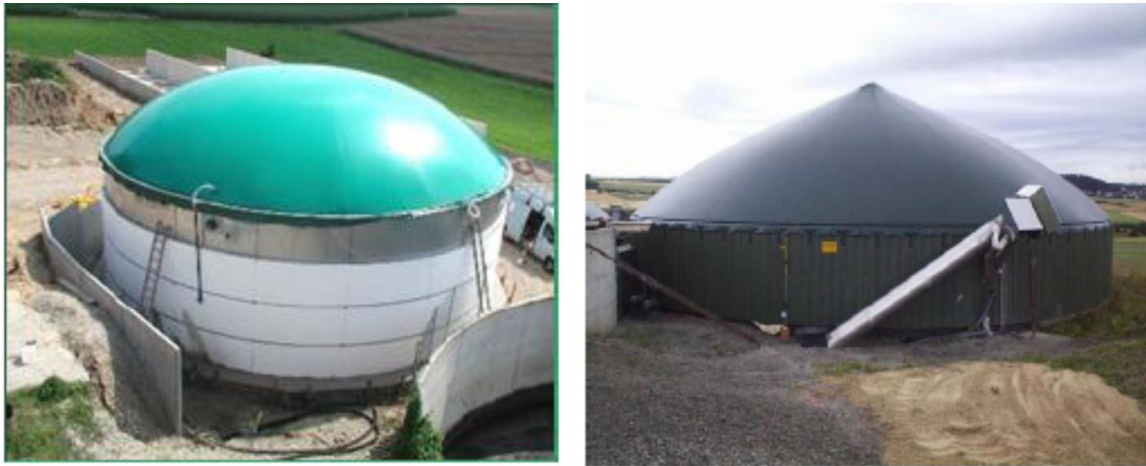
IMAGEN 11. Biodigestores agroindustriales con gasómetros de geomembrana de PVC en Alemania. Fuente: Gabriel Moncayo Romero, “Manejo ecológicamente compatible de las cuencas del Tungurahua” Universidad Técnica de Ambato, Ecuador
