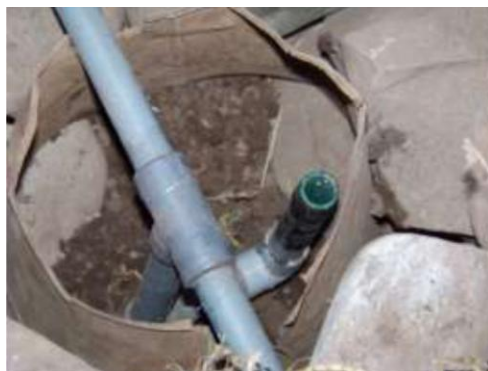
IMAGEN 5. Trampa de agua en U. Fuente: "Manual de instalación de un biodigestor familiar tipo manga para zonas alto-andinas". Universidad Politécnica de Cataluña.
