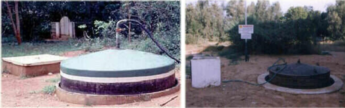
IMAGEN 12. Fotografías de biodigestores tipo Hindú. Fuente: Bárbaro Lugones López "Análisis de biodigestores". Cuba solar.
