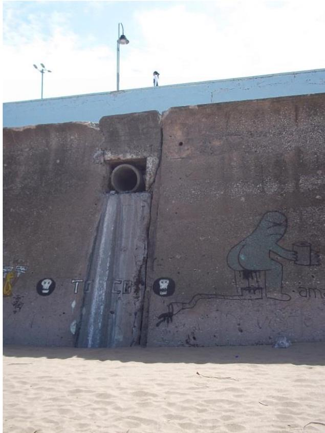
Foto N°3. Conducto pluvial desviado, año 2012. Fuente elaboración propia.
