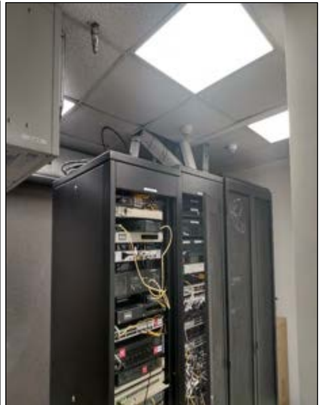
Se observa 1 tablero eléctrico seccionador y sala rack para distribución de redes
