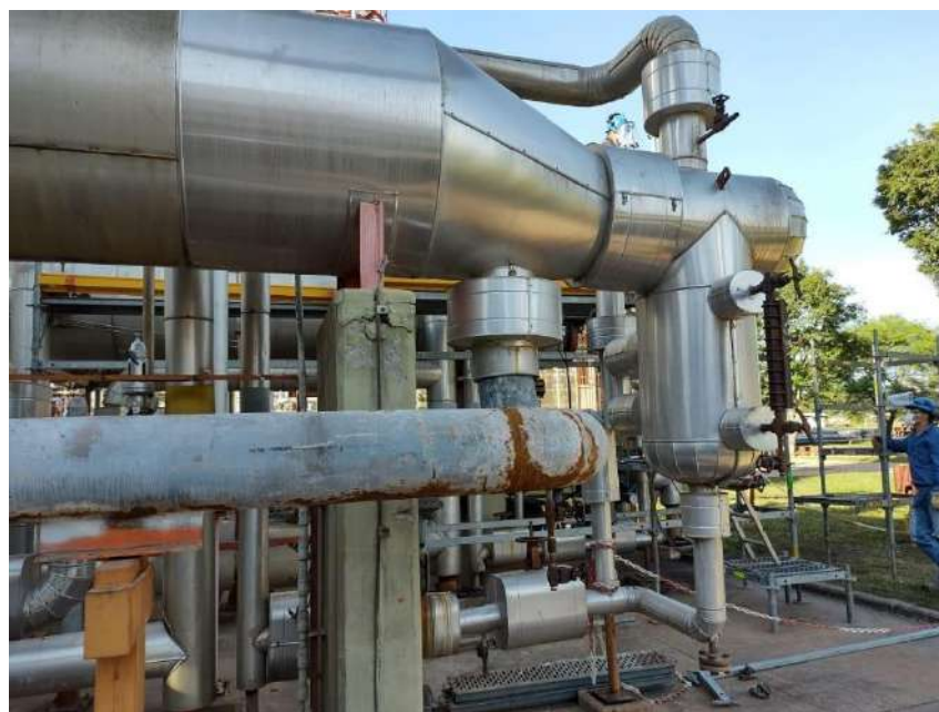
Tuberías que necesitan un nuevo aislamiento térmico.
