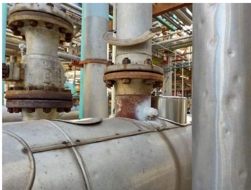
Tuberías que necesitan un nuevo aislamiento térmico.
