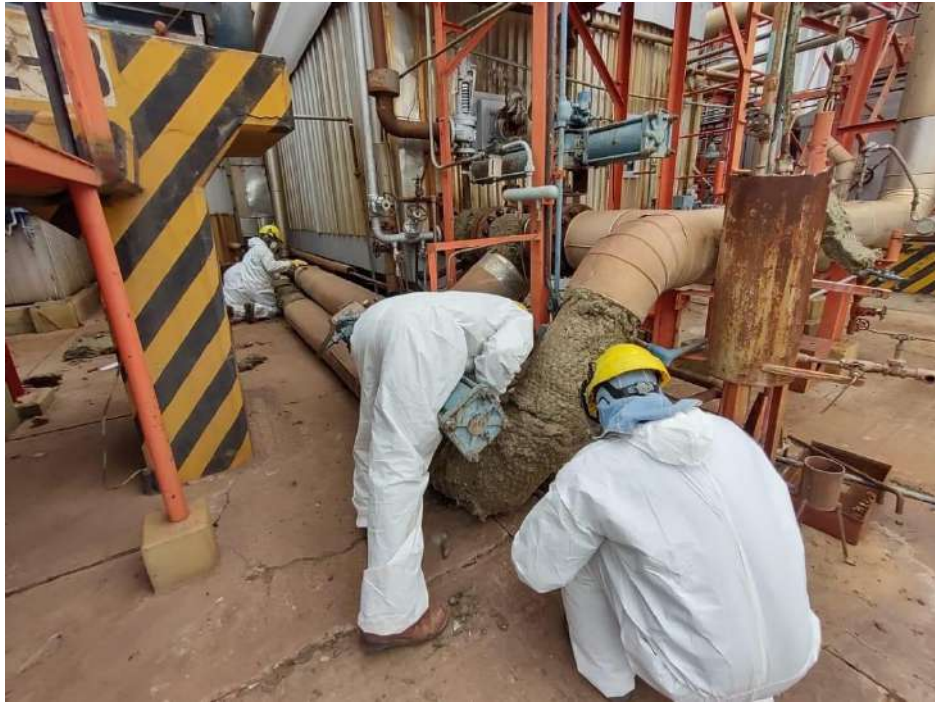
Señalización de precaución- franjas amarilla y negra.
