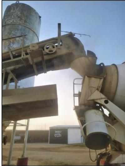
*Imagen N°: 16* Polvo de cemento y áridos en suspensión durante carga de insumos al Mixer.
