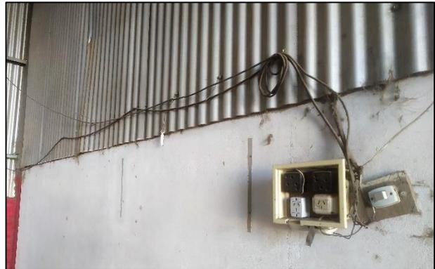
**Imagen N°: 40** Tablero precario situado en tinglado de resguardo de elementos varios.
