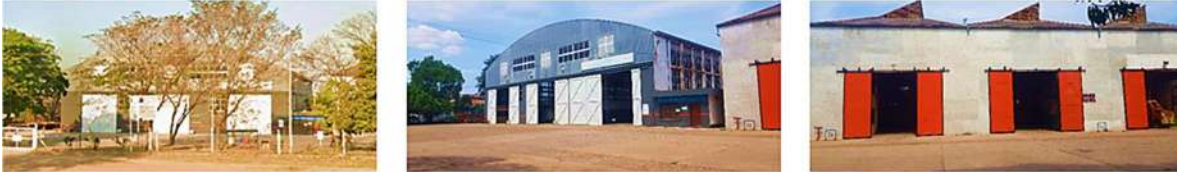
Vista anterior de los edificios N° 1, N° 2 y N° 3 de la empresa TALLERES NORTE S.A.
