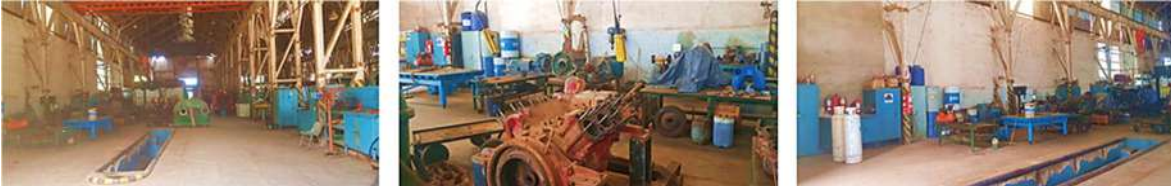
Vista general del sector "Mecánica" (edificio N° 3).
