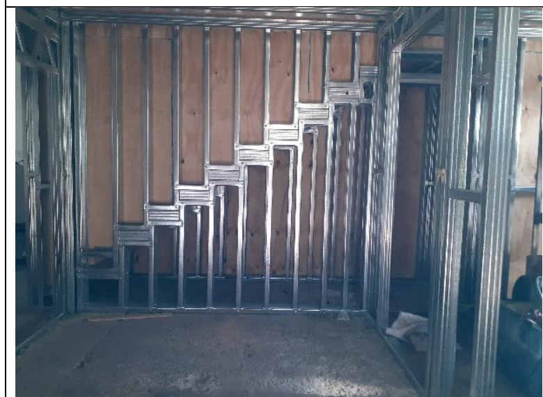
Estructura metálica para la creación de las divisiones de los espacios de ArgenWare
