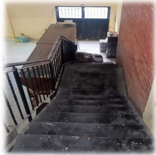
**Obstrucción y reducción de ancho de salida en vía de escape, que dirige desde depósito hacia salida de emergencia en sector salón de ventas. Se observa falta de bandas antideslizantes en los peldaños de la escalera.**
