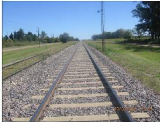
Foto 1.3 – Vía con balasto limpio
