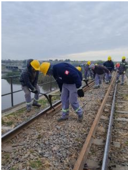
Levantamiento manual de rieles
