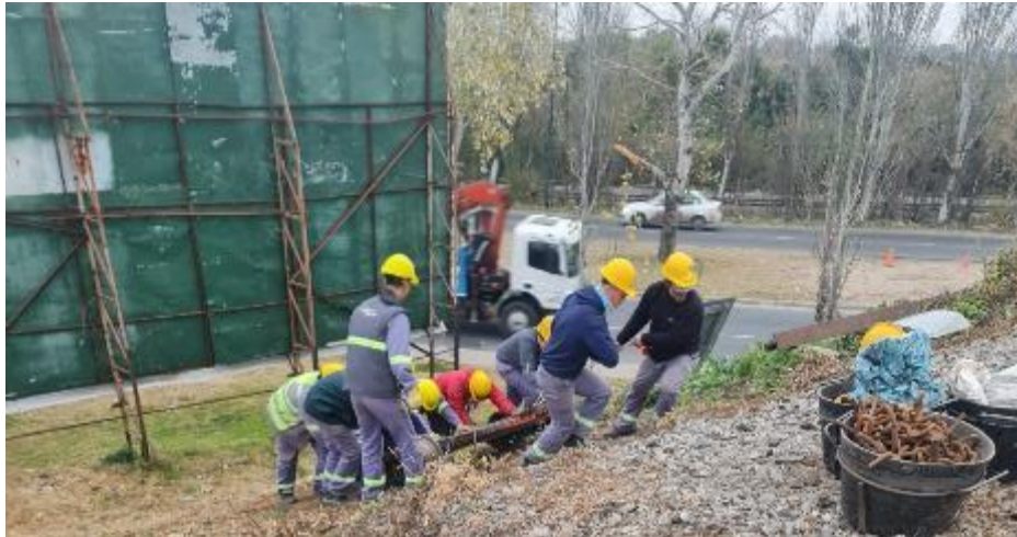
Transporte de durmientes por zorra de vía en pendiente
