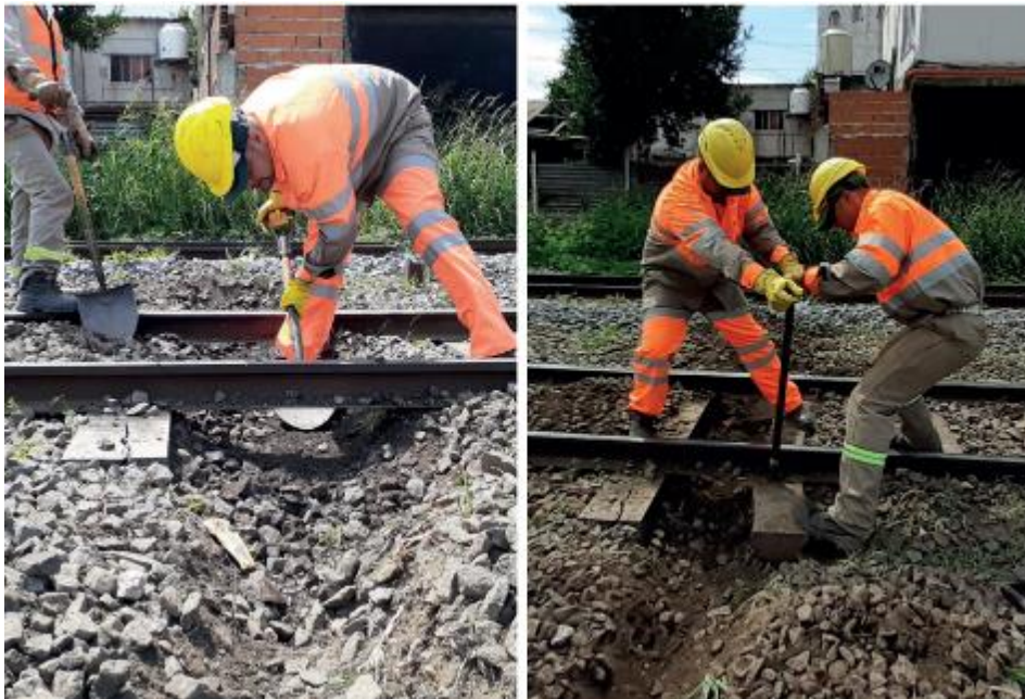
Colocación de fijaciones con ayuda de llave de vía
