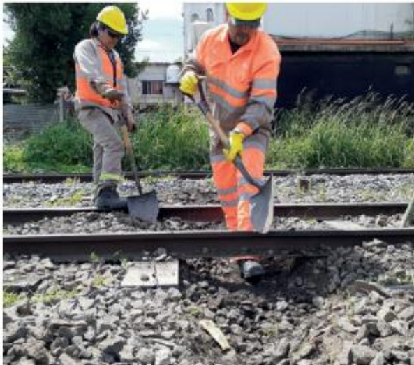
Reemplazo de durmiente
