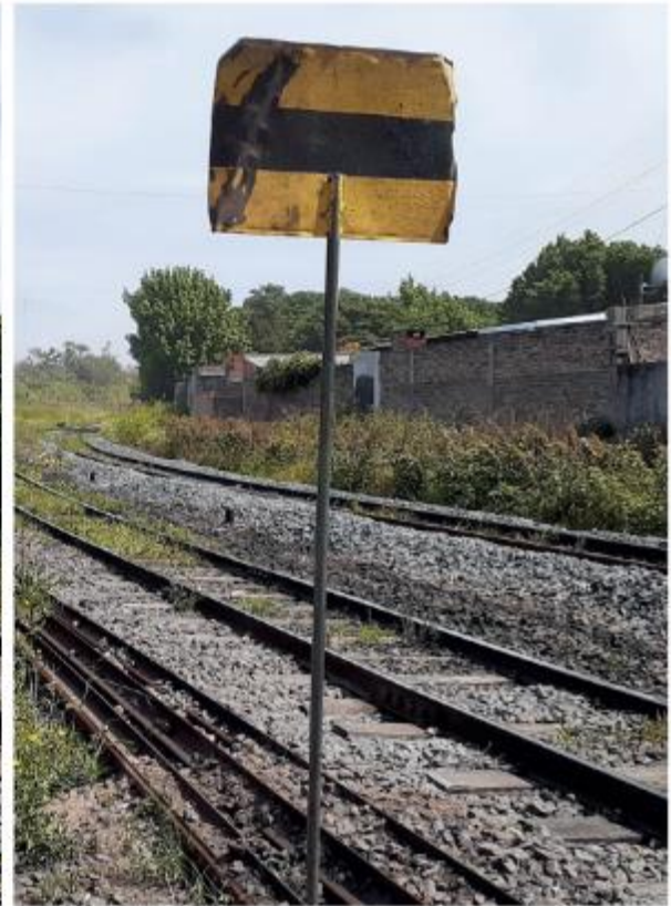
Bandera que indica cuadrilla trabajando
