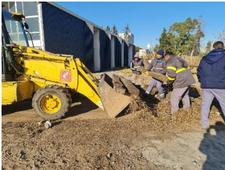
Levantamiento manual de durmientes para transportarlo en retro pala
