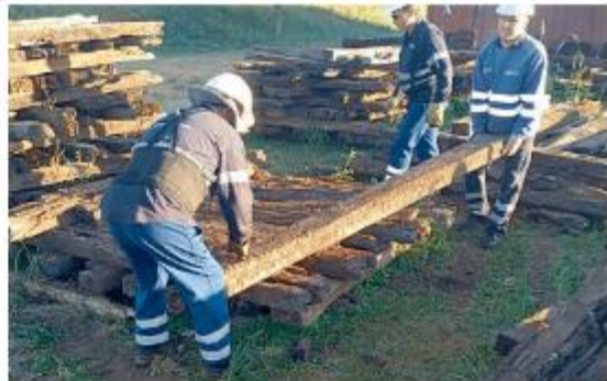
Movimiento manual de durmientes de madera
