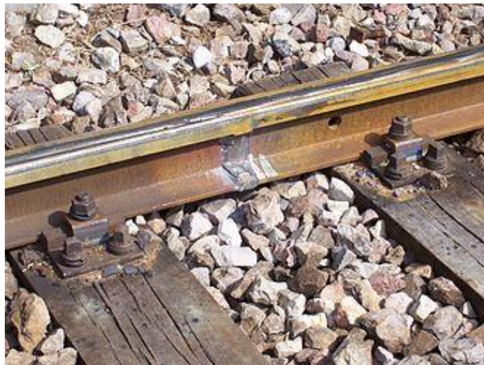
Soldadura aluminotérmica de rieles.
