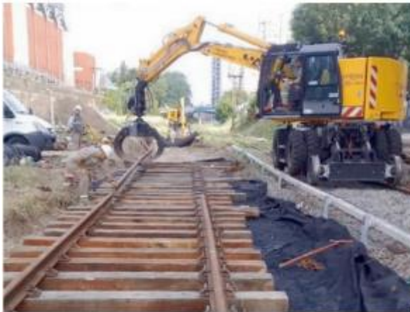
Colocación mecánica de rieles
