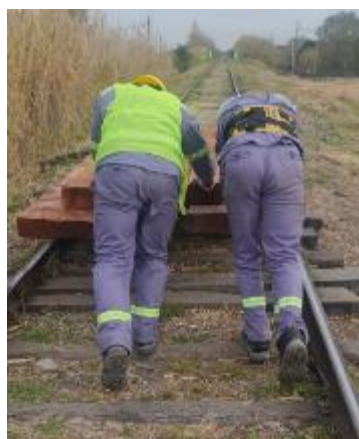
Traslado de durmientes por medio de una zorra de vía.
