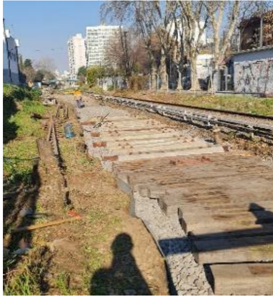
Colocación de durmientes nuevos
