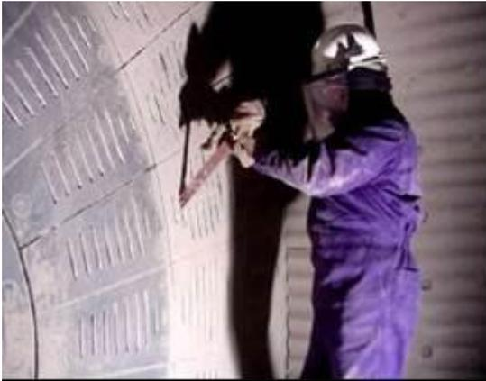
El cambio de placa consta del ingreso al molino, cortar el bulón de vinculación y retirar placa rota y reemplazar por nueva.
