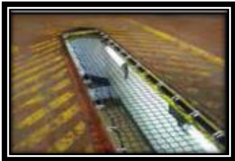
FOSA CUBIERTA MEDIANTE RED DE SEGURIDAD
