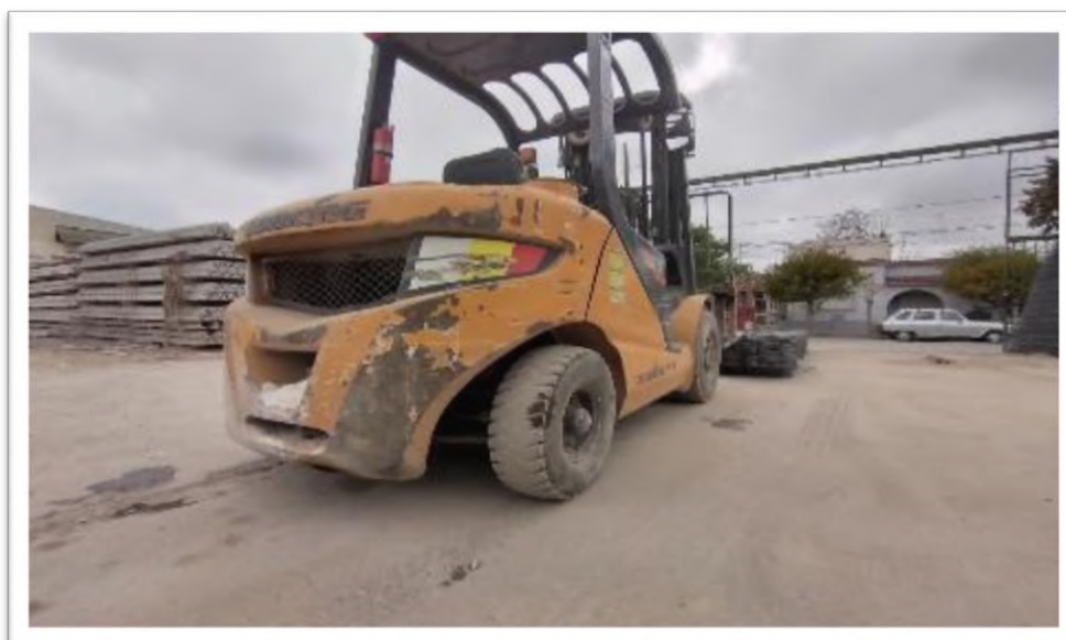
ESTADO GENERAL DEL PISO DE INGRESO Y EGRESO DE MATERIAL
