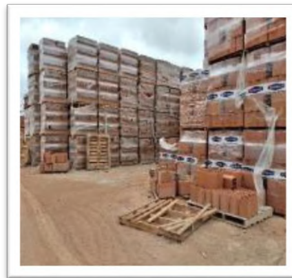
APILAMIENTO SOBRE SUELO NIVELADO
