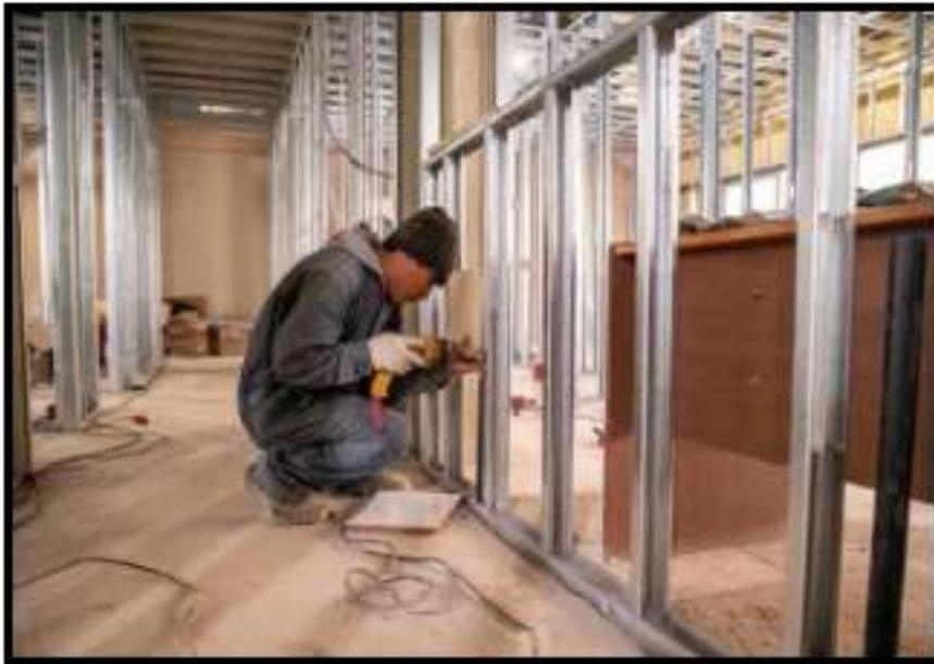
IMAGEN N 3: SE OBSERVAN DESVIOS. CABLES A NIVEL DEL PISO, FALTA DE EPP.
