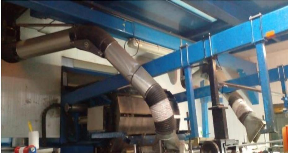
*Foto 8. Kraisellvurd N. (2023). Sistema de mangas de extracción de gases [Foto]. Autoría Propia*
