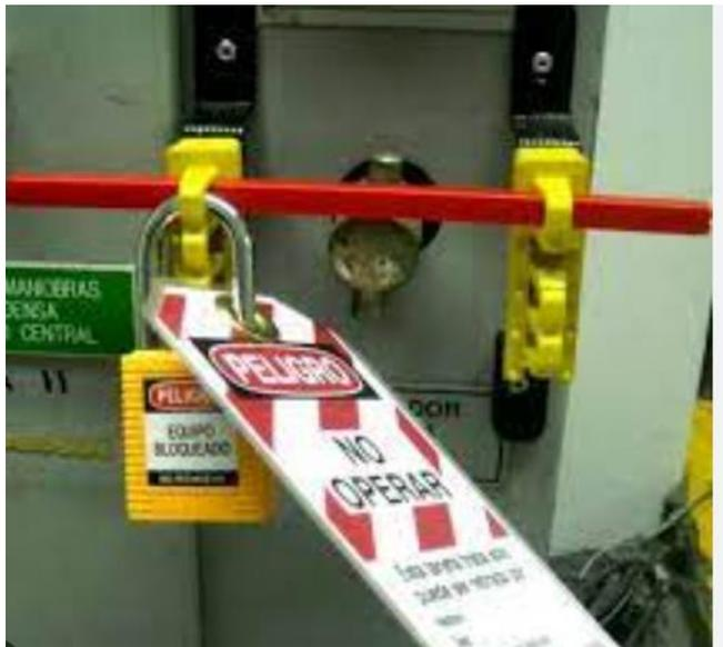
*Foto 21. Javeriana (2015 ). implementación de bloqueo y rotulado de energía de seccionado [Foto]. Recuperado de:*
