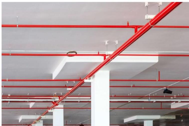
Foto 19. Iotechnology (2023). Sistema de cañerías conectada a la red de incendio [Foto]. Recuperado de <https://iotechnology.pe/sistema-contra-incendio/rociadores-contra-incendios-2/>
