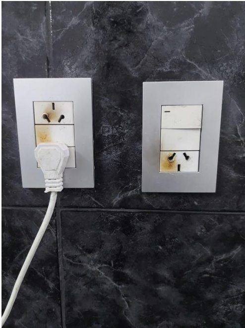
Figura N°23 y 24 – Tomacorriente defectuosos e inadecuados para su uso.
