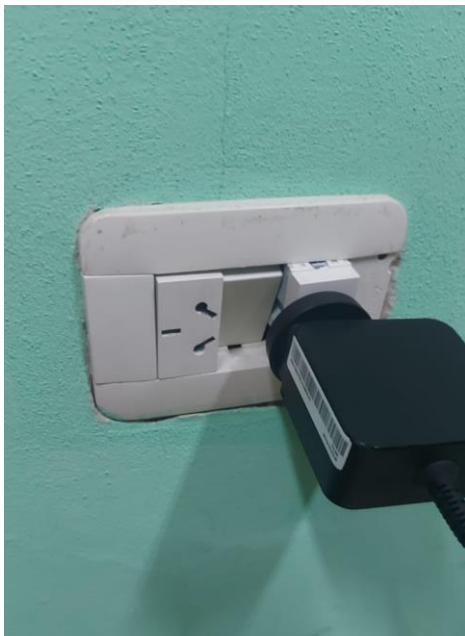
Figura N°15 y 16 – Tomacorriente roto.
