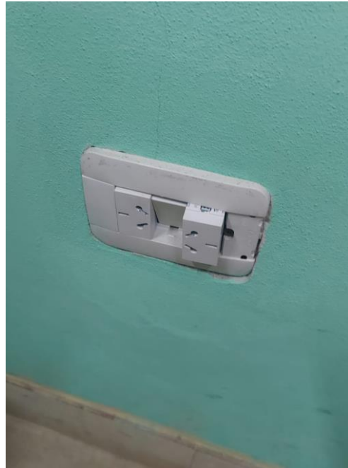
Figura N°23 y 24 – Tomacorriente defectuosos e inadecuados para su uso.
