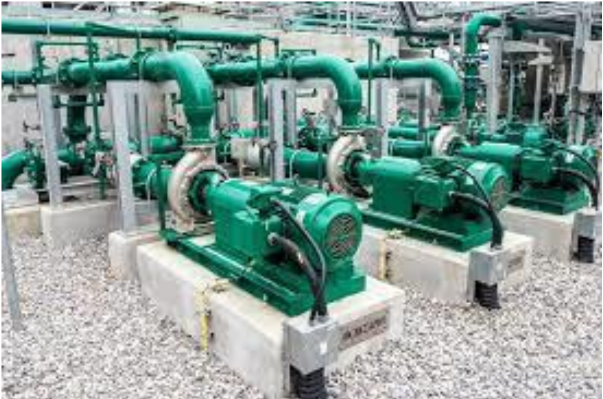
Cañerías en sala frío
