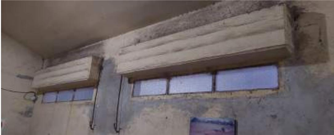
**Figura 25** – Rejillas de ventilación manuales.
