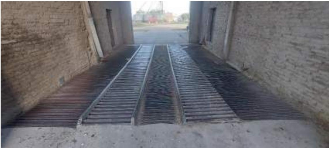
**Figura 6** – Boca de descarga por gravedad.
