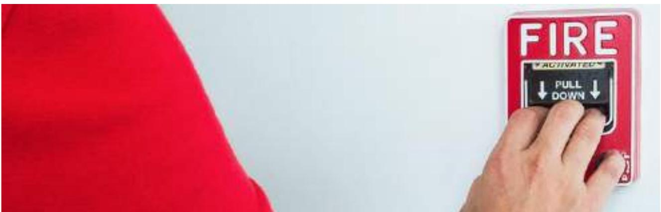
Figura 57 – “Pulsa hacia abajo para activar” – Pulsador de emergencia de Fuego
