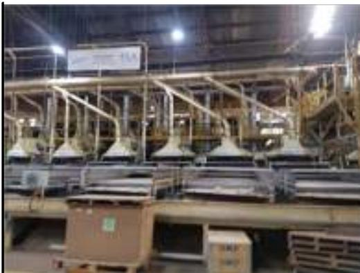
*Imagen 55 - Ductería y punto de extracción ventilación localizada de zaranda en repicking*
