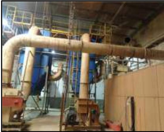
*Imagen 61 - Sistema de captación de material particulado*
