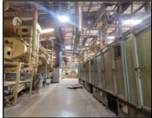
*Imagen 52 - Área de picking y repicking – campanas de extracción localizadas en zarandas y ductería múltiple*
