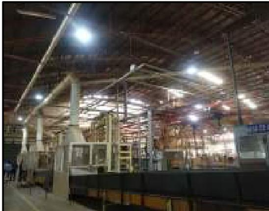
Imagen 46 - Bale Feeding – zona de alimentación – campanas de extracción y ductería.
