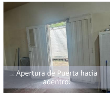
Puerta de salida de Emergencia obstruida
