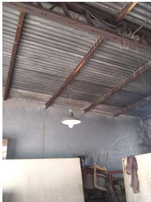
Ilustración 5 Luminaria Quemada
