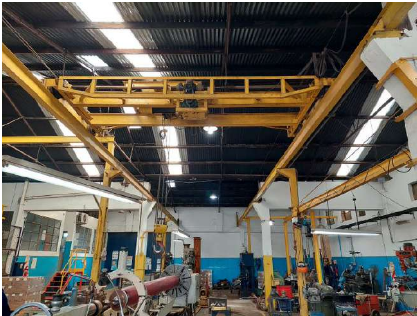
Fotografía de la iluminación del taller
