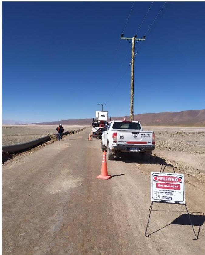
**Figura 4.12 - Señalización del area de trabajo**
