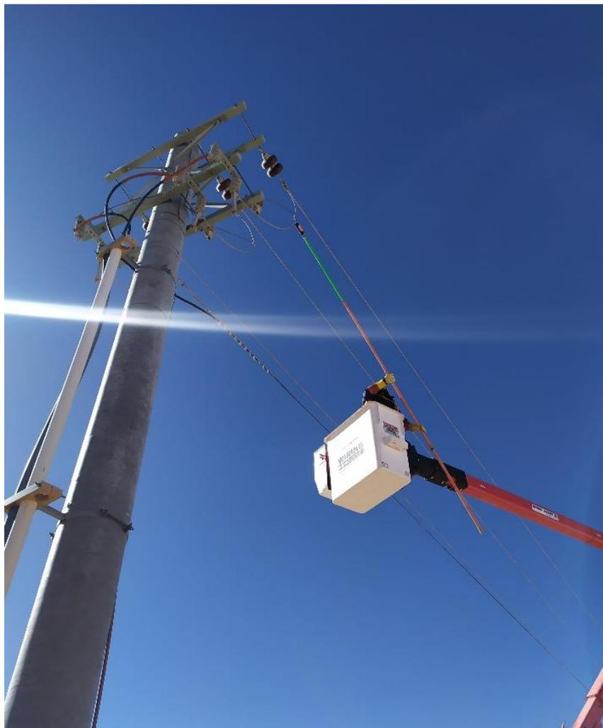
**Figura 1.17 Colocación de puestas a tierra**
