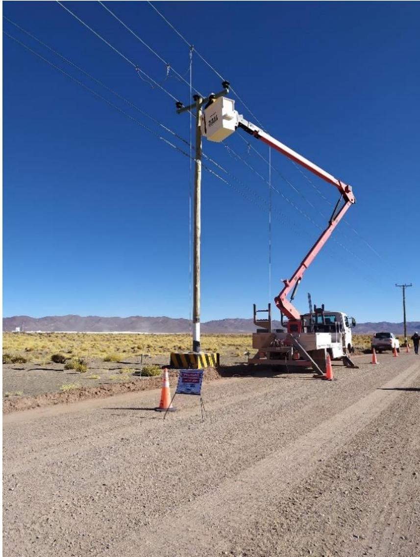
**Figura 1.19 – Señalización del área de trabajo**
