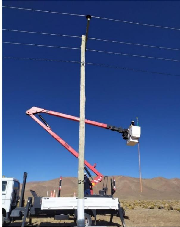
**Figura 4.15 - Deteccion de ausencia de tension**
