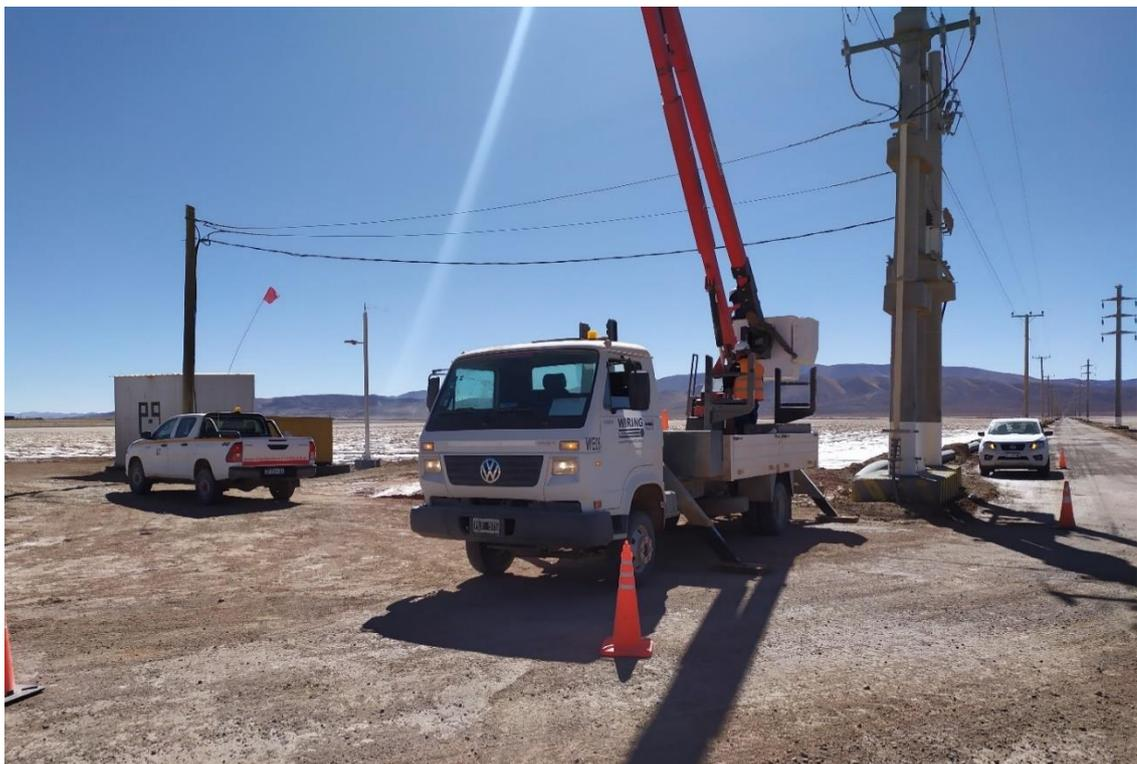
**Figura 4.13 - Despliegado de estabilizadores**
