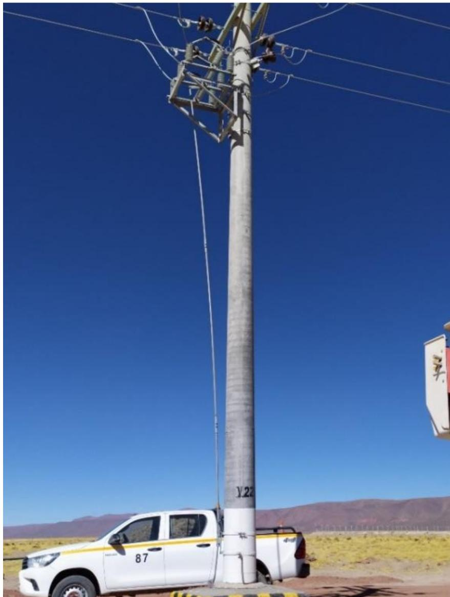
**Figura 1.8 – Seccionador a cuerno**
