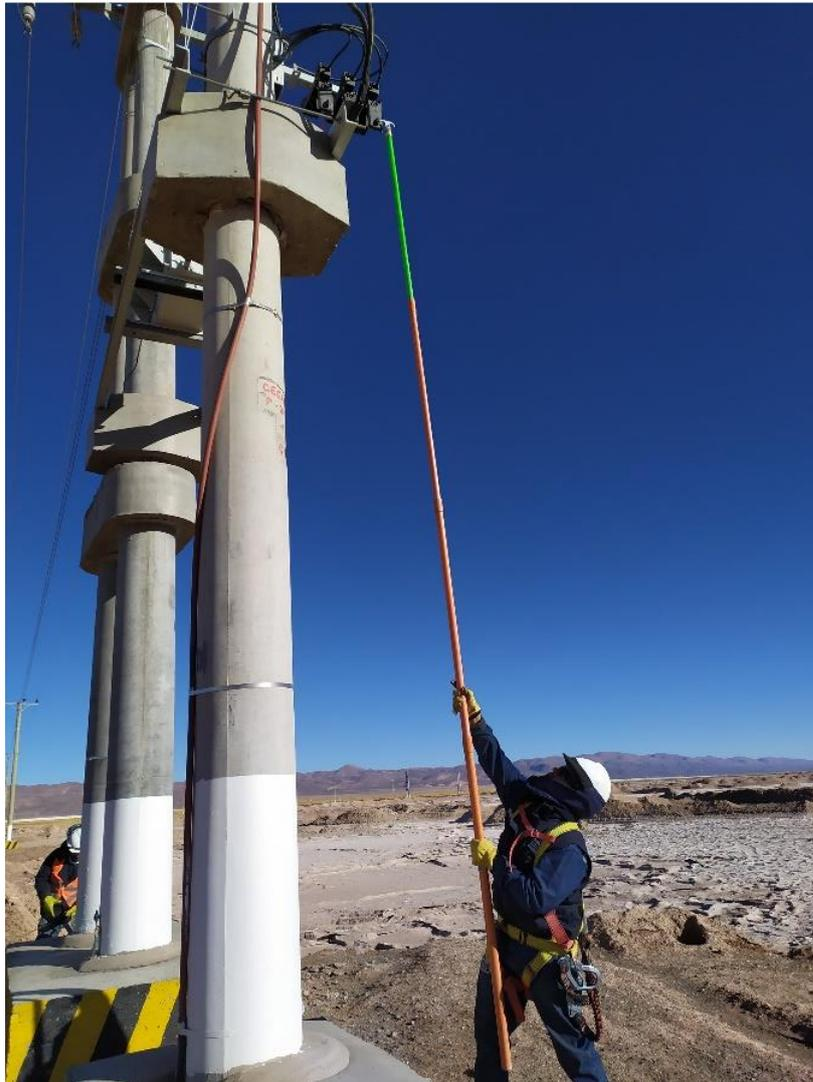
**Figura 1.14 - Apertura de APR (fusibles)**
