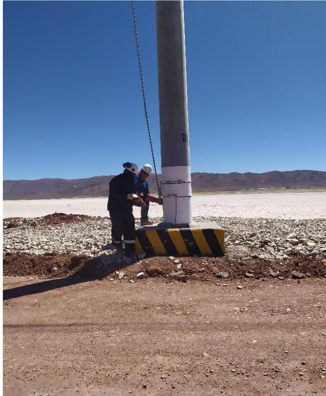
**Figura 1.12 - Apertura de seccionador a cuerno**
