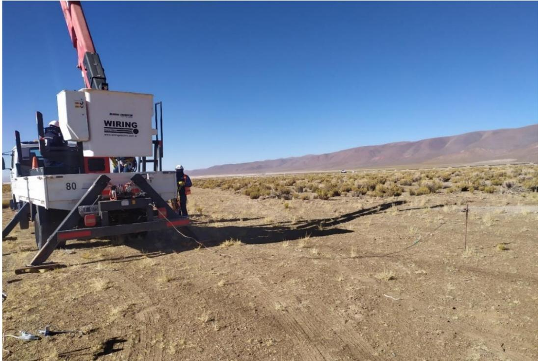
**Figura 4.13 - Colocacion de puesta a tierra de hidroelevador**
