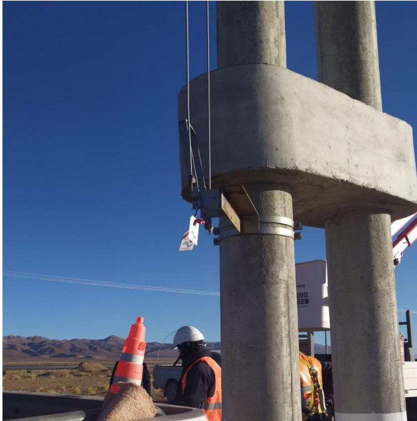
**Figura 1. 15 - Bloqueo y colocación de candado en seccionador**
