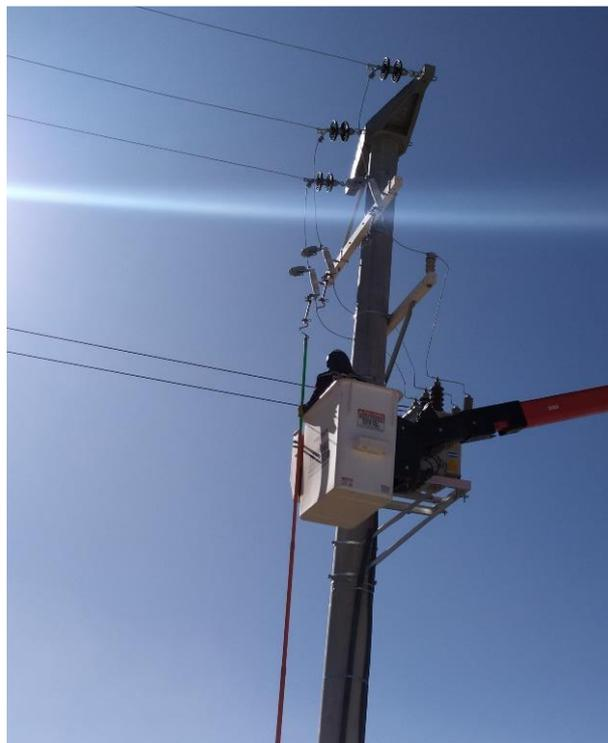
**Figura 1.13 - Apertura de seccionadores XS**
