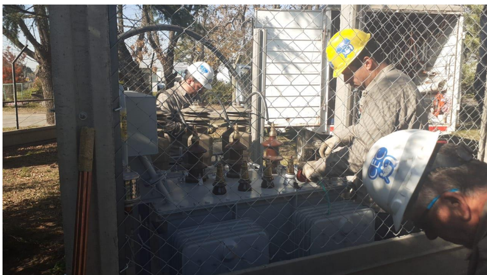
Mantenimiento de los transformadores
