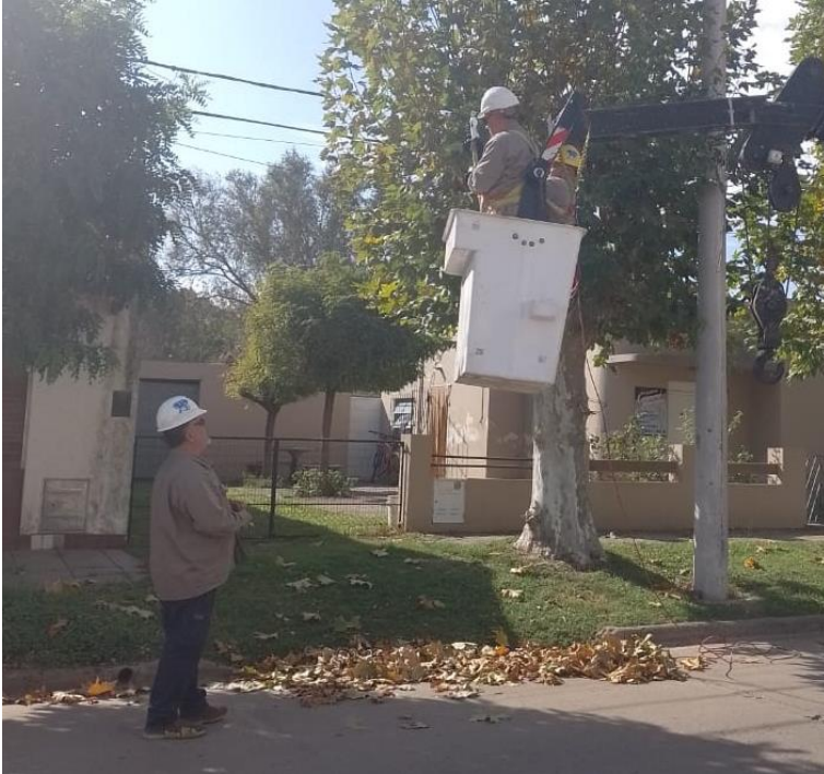
Trabajos con Hidroelevador
