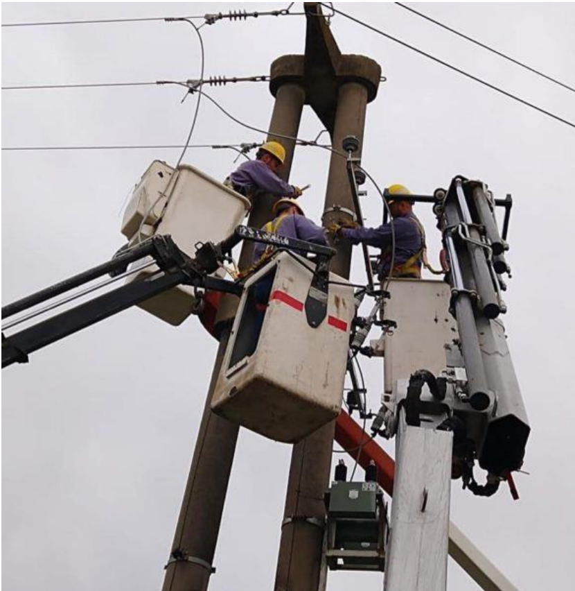
Operarios de la Cooperativa realizando tareas de mantenimiento
