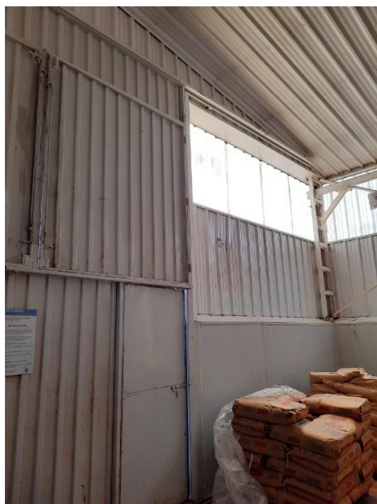
FIGURA 32 – Foto Planta de Pastas. Lugar donde se colocarán los nuevos.
