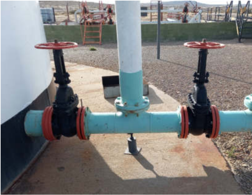
BLOQUEOS CON BRIDAS CIEGAS
