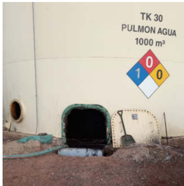
Boca de ingreso a nivel del suelo
