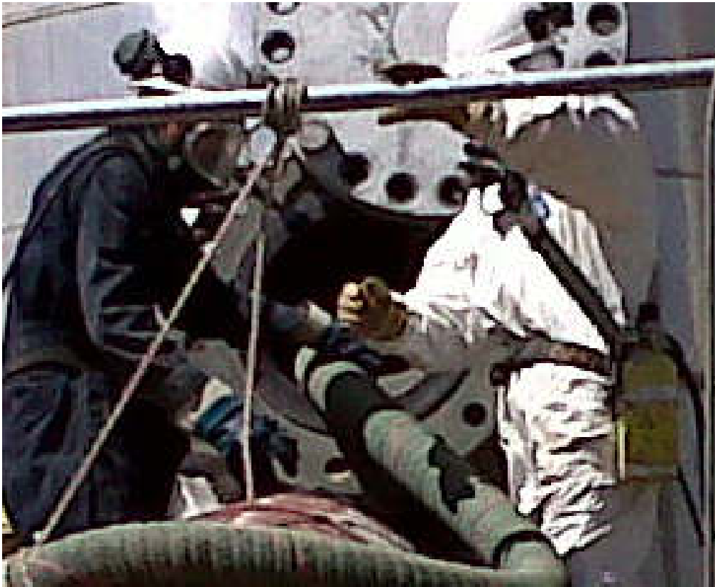
LIMPIEZA TAMIZ MOLECULAR - MATERIAL DE RELLENO SÓLIDO (EQUIPO VERTICAL)
