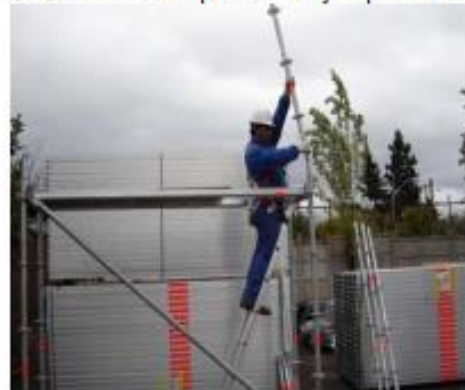
8- Colocación de baranda superior
