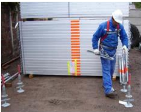
1- Colocación de bases
