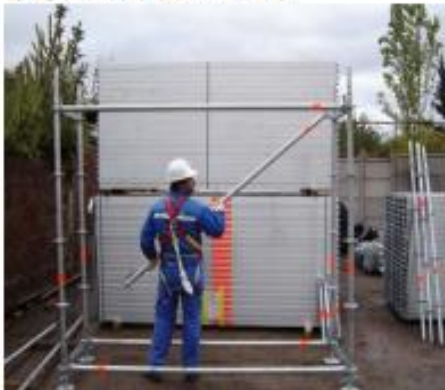
7- Colocación de baranda intermedia
