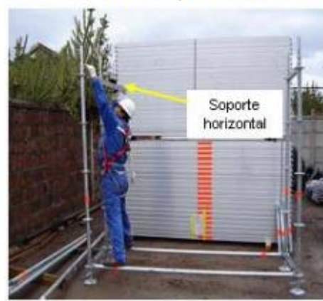
4- Colocación de soportes horizontales
