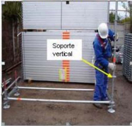
3- Colocación de soportes verticales
