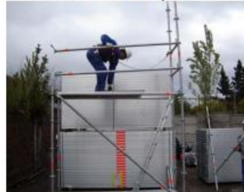
9- Colocación de rodapié alrededor del andamio
