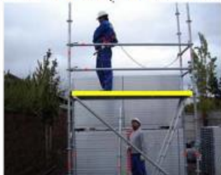
9- Colocación de rodapié alrededor del andamio
