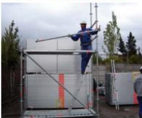
9- Colocación de rodapié alrededor del andamio
