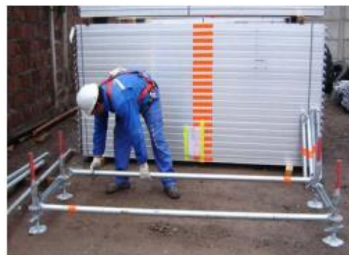
2- Colocación de marco inferior
