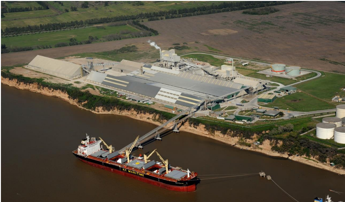
Vista aérea del complejo Terminal de fertilizantes argentinos.
