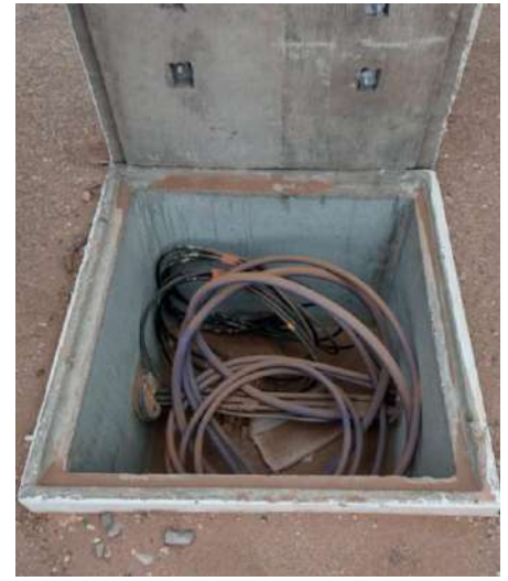
Imagen 5: Fosa de BT y comunicación.
