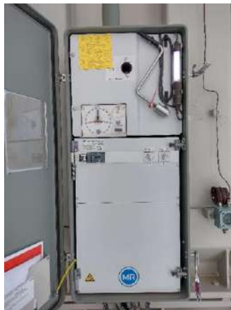
“Tablero de Regulación de tensión MR”
