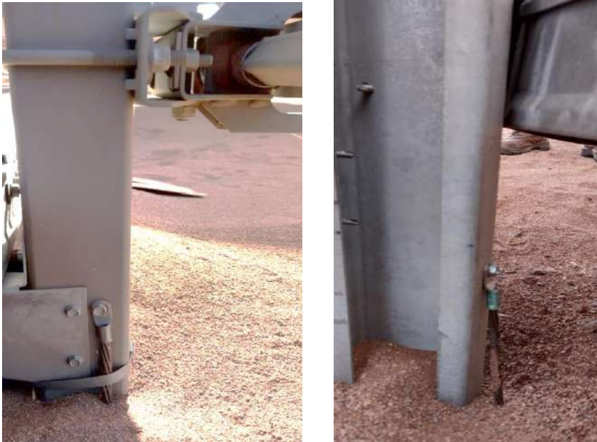
Imagen 11: PAT inca central y PAT de MCB
