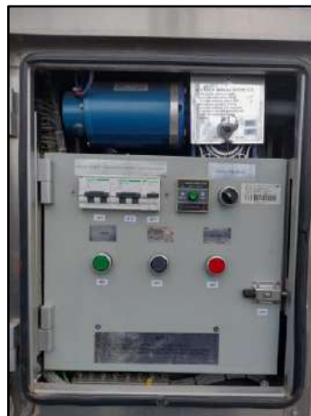
Imagen 8: Tablero de comando de seccionador de línea 345KV. Imagen 9: Vista general de tablero de comando de seccionador de línea 345KV.
