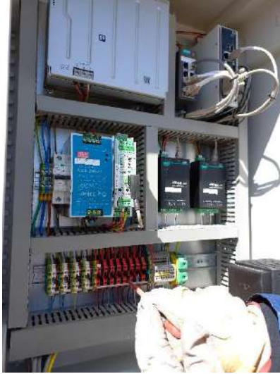
Imagen 3: Re-ajuste de bornes en el tablero
