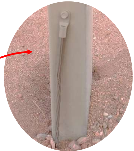
Imagen 10: PAT en inca del extremo de los trackers
