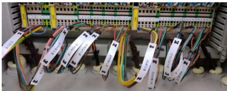
Imagen 20: Interior MCB sellado con espuma
