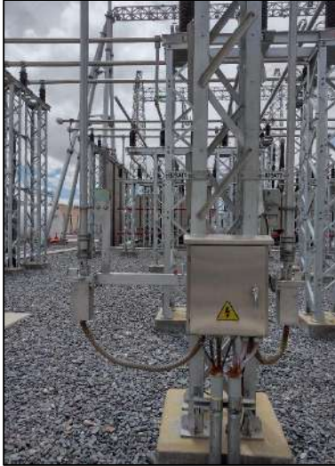
Imagen 4: Disposición de tablero y cajas de comando de un seccionador de PAT.
