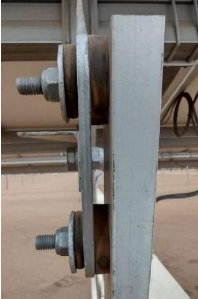
Imagen 9: T-bushing en arco
