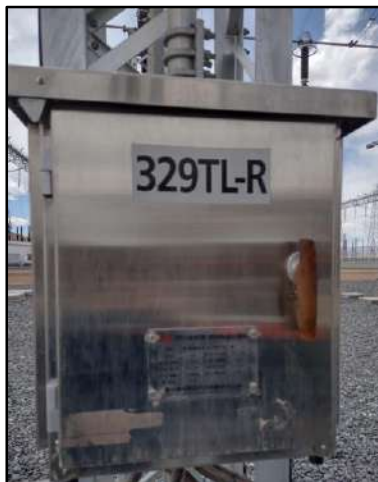
Imagen 8: Tablero de comando de seccionador de línea 345KV. Imagen 9: Vista general de tablero de comando de seccionador de línea 345KV.
