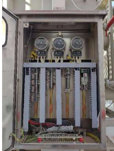
“Tablero de Medición de Temperatura
