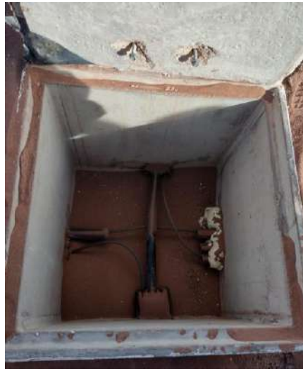
Imagen 4: Fosa de fibra óptica.
