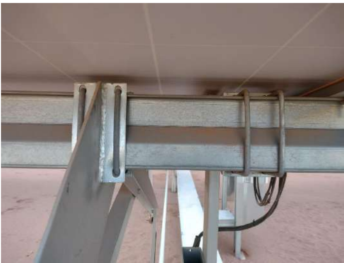
Imagen 8: U-bolt para montaje de girden
