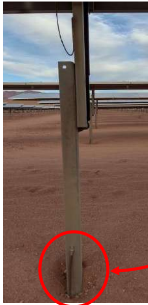
Imagen 10: PAT en inca del extremo de los trackers
