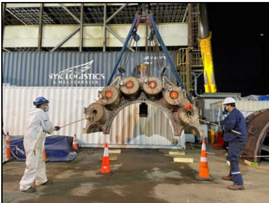
Figura N°37 - Buena Práctica de izaje y traslado de partes
