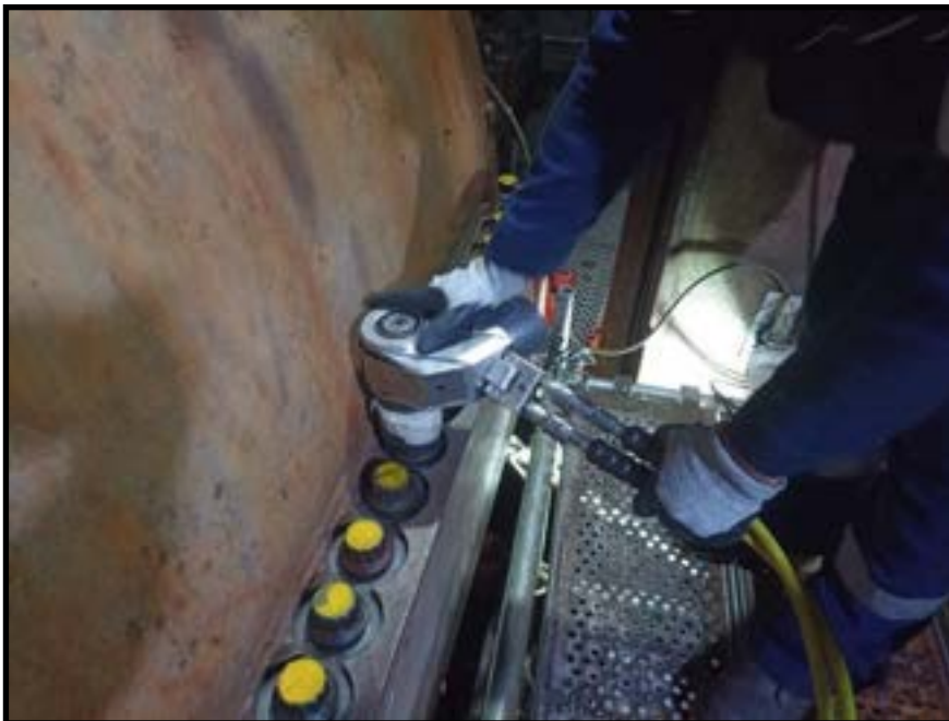
Figura N°12 – Colocación de cabezal para afloje
