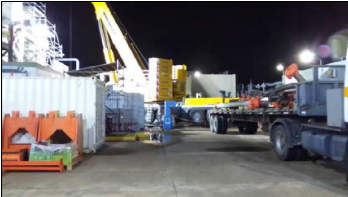
Figura N°43 - Maniobra traslado de partes hacia camión de carga
