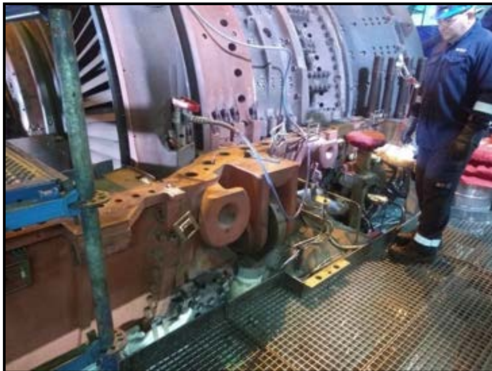
Figura N°14 – Distancia prudencial durante accionamiento de la herramienta
