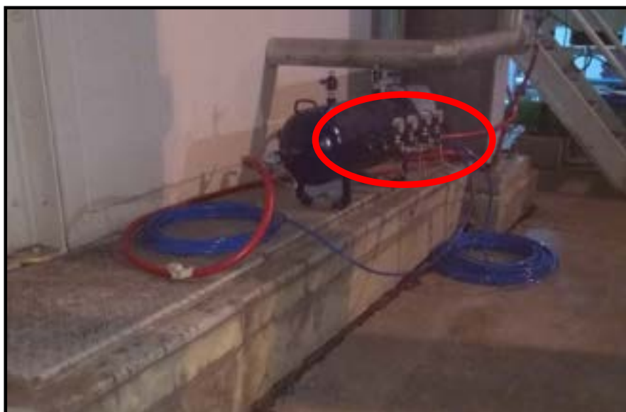
Figura N°45, 46- Colocación de accesorio anti-latigazo para mangueras
