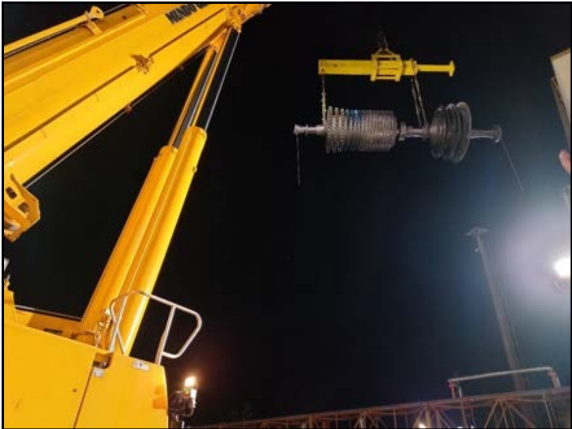
Figura N°44 - Levantamiento de Rotor de Turbina 60tn
