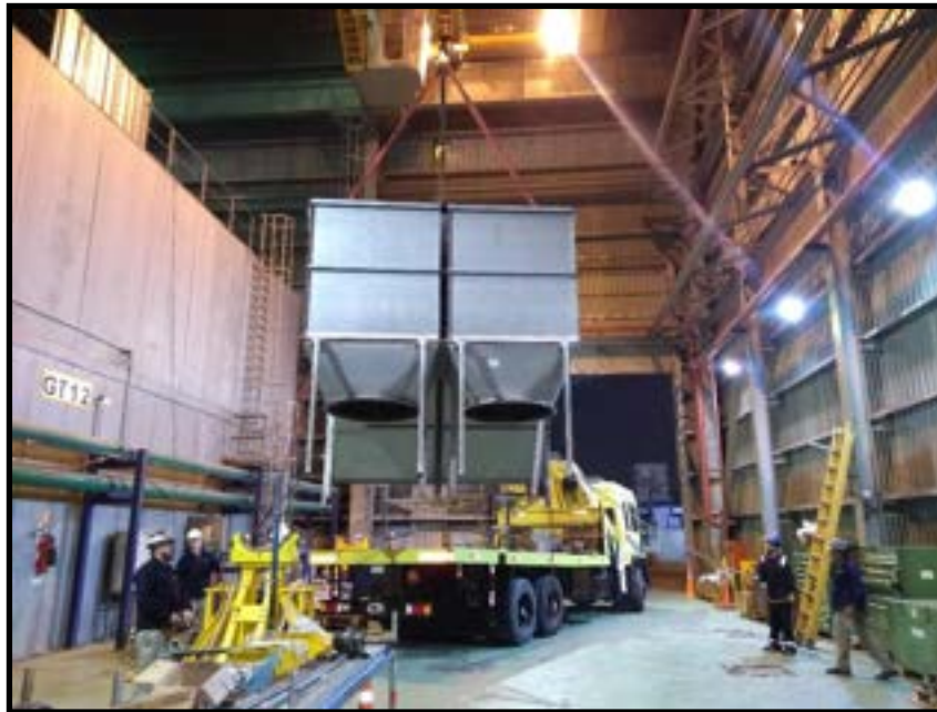
Figura N°38 - Operación de izaje con Puente Grúa
