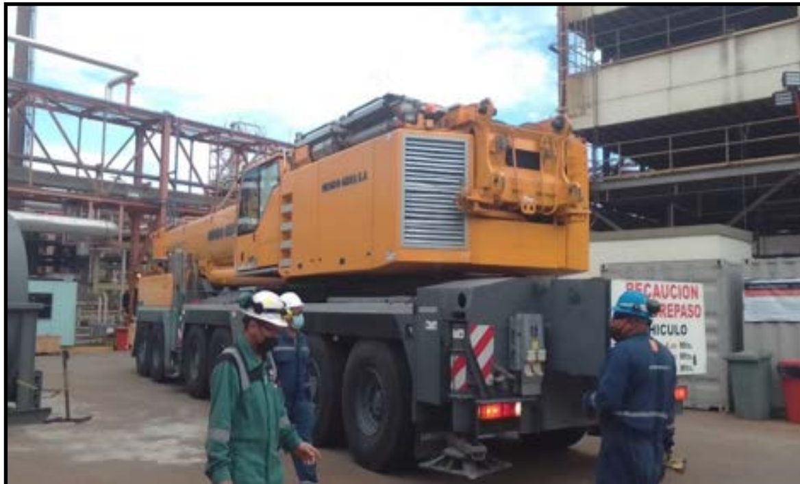
Figura N°41 - Posicionamiento de Grúa Móvil
