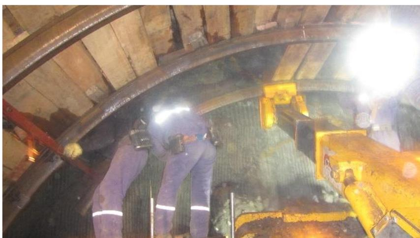
**Chiflones:** Se realizan dos galerías paralelas separadas por un pilar de 30m entre ejes, estas galerías tienen una sección de 18 a 20m cuadrados. Una de ellas puede utilizarse para transporte de material y de personal; y la otra para evacuación de mineral de carbón de estéril, ingreso de servicios (agua, aire, energía) según la proximidad de cada servicio y ambas son utilizadas para brindar ventilación (ingreso
