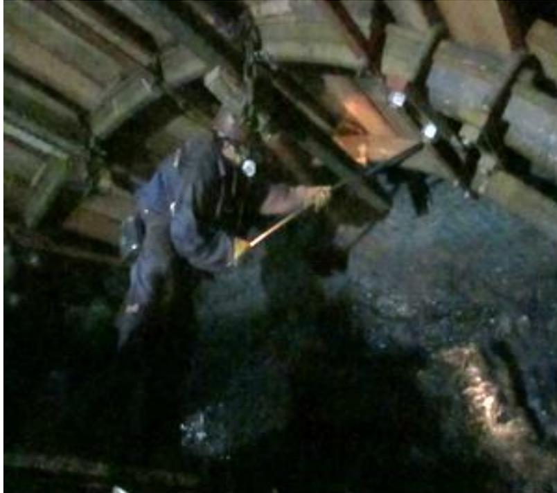
Para la colocación de coronas, la misma se hace sobre 2 vigas (marca long-bard) estas se fijarán mediante cadenas ubicadas en la 1ra y 3ra corona empleando cuñas, la distancia entre la corona y el ultimo arco debe ser de 90cm en zonas donde las características de la roca se evalúen como estables.
