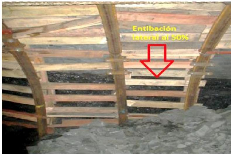
perpendicular sobre la base y así sucesivamente hasta acercarse al techo sobre los últimos 2 se debe cubrir toda la superficie con planchuelas de madera.
