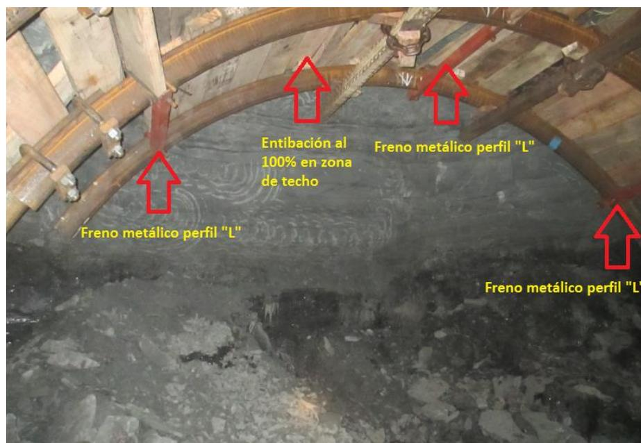
Al momento de colocar la corona la misma es sujeta en ambos extremos con listones de cinta cortados longitudinalmente utilizados como cuerdas contra el último arco, separados por frenos fabricados con tablas con las dimensiones que se necesiten para establecer la distancia entre arcos.
